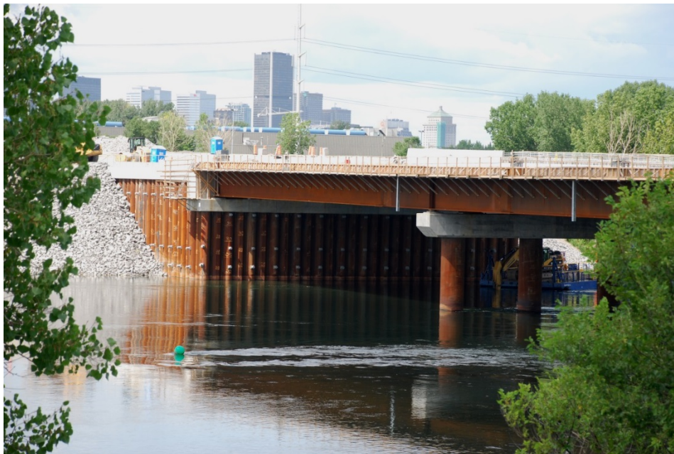
FIGURE 2 – CULÉE AXE 1 DU PONT DE CONTOURNEMENT CULÉE SUR PAROI COMBINÉE PIEUX - PALPLANCHES
