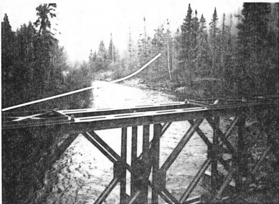
PHOTO 5: Vue de la rivière Mitchinamékus en direction nord. La ligne blanche indique la position approximative du futur pont qui remplacera le pont Bailey en avant-plan.
