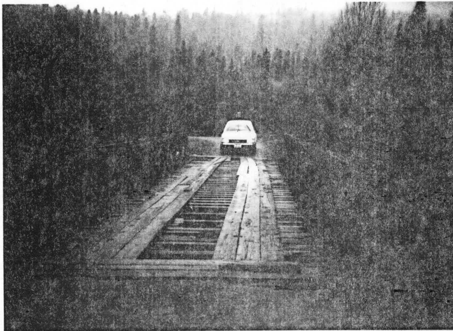
PHOTO 7: Vue d'ensemble du pont Bailey au chainage 7+840.
