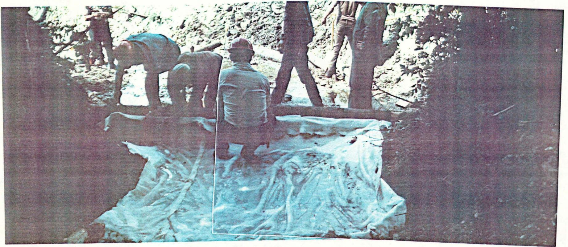
Figure 11: Installation de la membrane géotextile.
