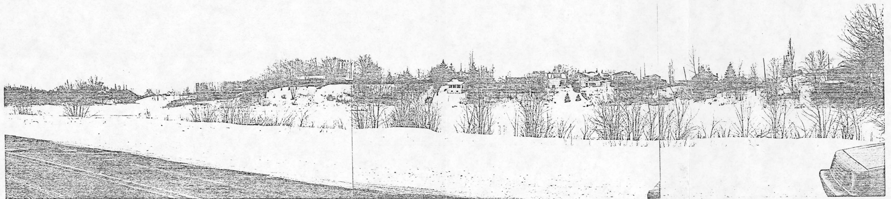
1.21 à 1.26 Vue sud-ouest boul. Salaberry
