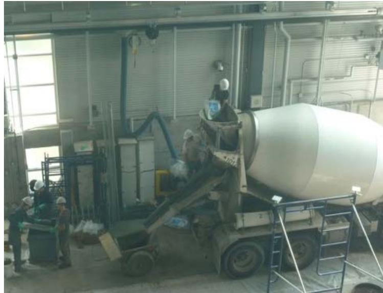
Figure 4.3 : Ajout des fibres et optimisation des quantités d'adjuvant à l'ÉPM
