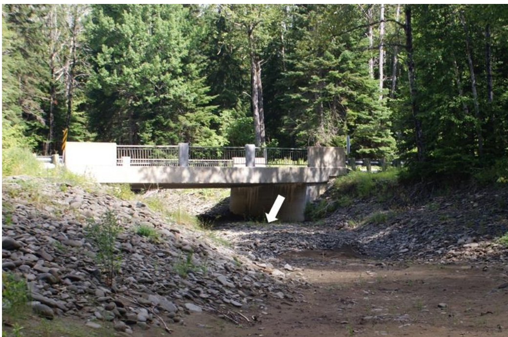
Figure 24. Accumulation de sédiments dans le secteur de la traverse P-02804. (Ruisseau d'Argent, été 2013)
