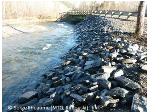
16 novembre 2011 (après enrochements)
