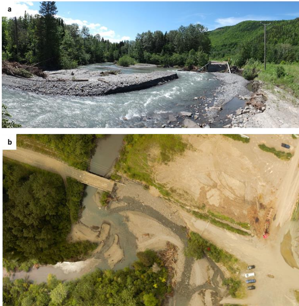
Figure 61. Érosion de la route Notre-Dame-Ouest à la confluence entre la rivière Marsoui (branche Ouest) et Petite Marsoui (branche Est) par la crue Arthur. a – Vue à partir de la route et b – à partir d’une caméra aéroportée.
