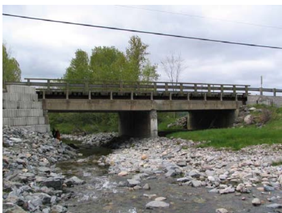
a) Vue du pont
