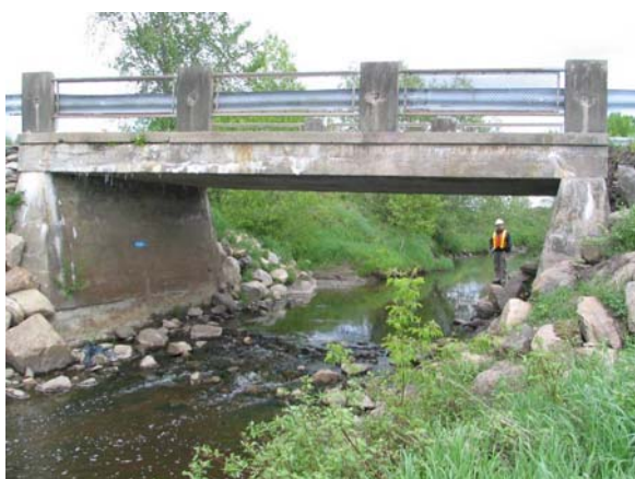
a) Vue du pont
