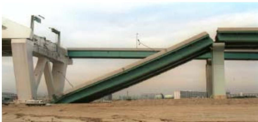
**Figure 1 – Effondrement de travée dû à une perte d'appui (Kobé 1995)**
