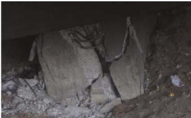
(c) Rupture par cisaillement-compression Chili 2010 (Mitchell *et al.* 2012)
