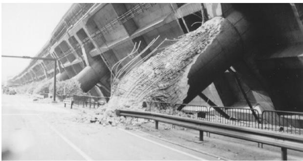
(a) Rupture due à la terminaison prématurée de l'armature, Kobé 1995 (Chen and Duan 2003)
