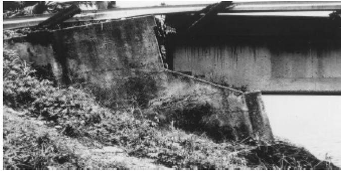
**Figure 7 – Glissement et rotation de la culée, Costa Rica 1990**
