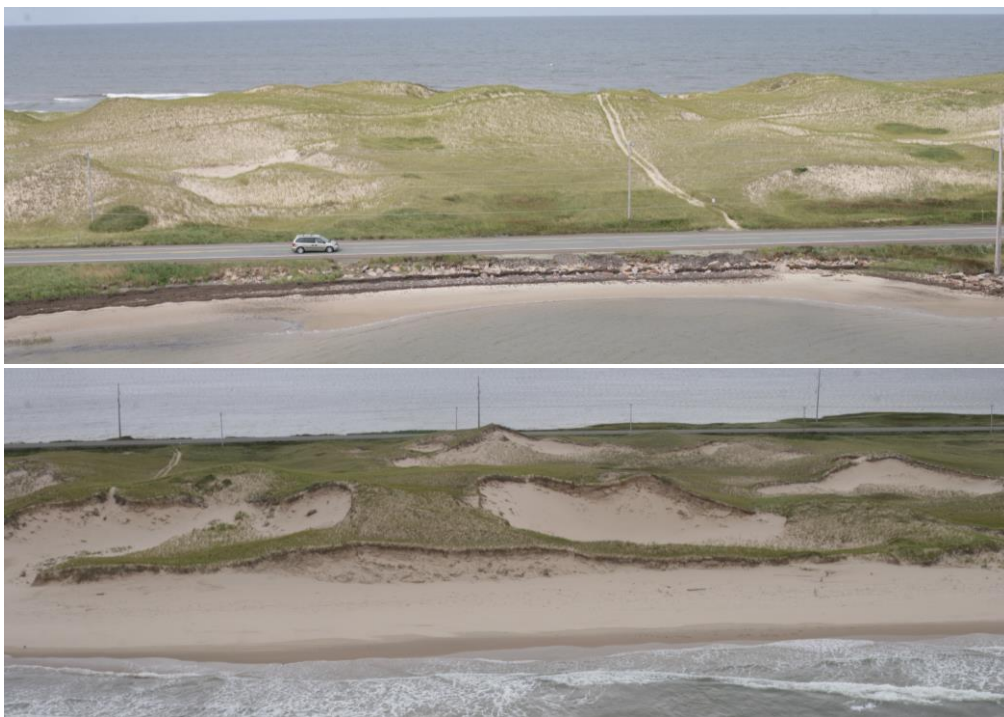
Figure 123. Exposition à la submersion à moyen terme et érosion à long terme (© LDGIZC- UQAR, septembre 2010)
