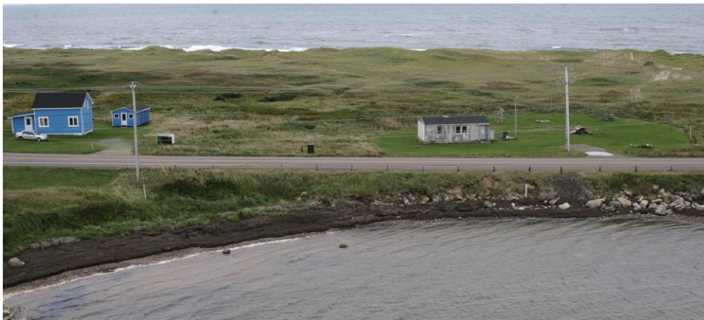
Figure 124. Érosion via l'intérieur de la lagune (PTL072 et 073) (© LDGIZC-UQAR, septembre 2010)
