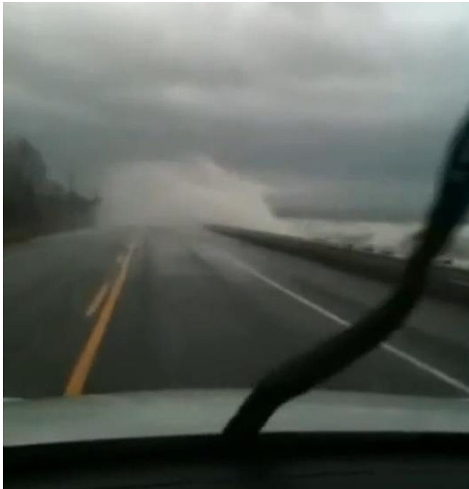
Figure 36. Vagues déferlant par-dessus le mur de protection de la route 132 à Maria durant la tempête du 6 décembre 2010 (© Stéphane Montmagny)
