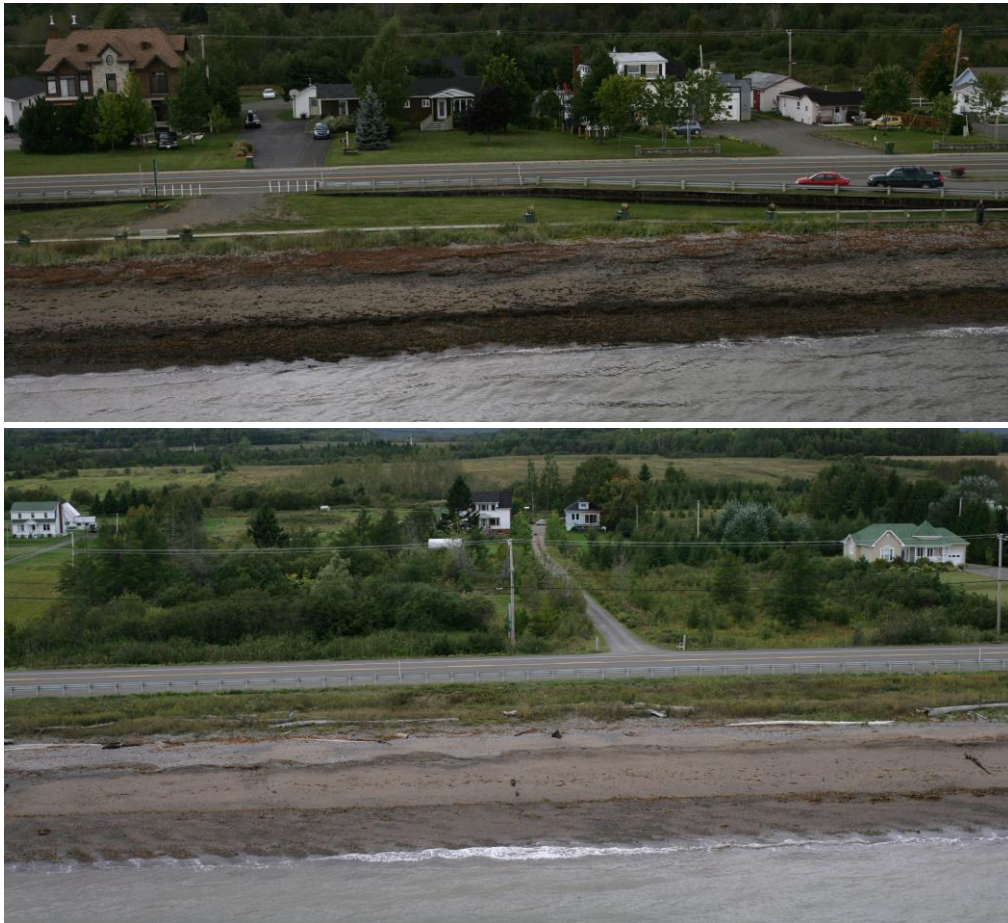
Figure 114. Segments moins vulnérables dus à la présence d'une terrasse de plage en avant du mur (© LDGIZC –UQAR)
