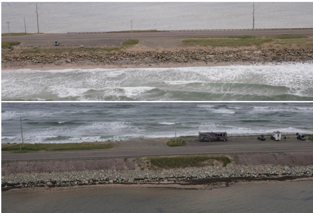
Figure 125. Sites protégés – si non entretenus deviendraient des sites très vulnérables - haut : vue vers l'intérieur – bas : vue vers l'extérieur (© LDGIZC-UQAR, septembre 2010)
