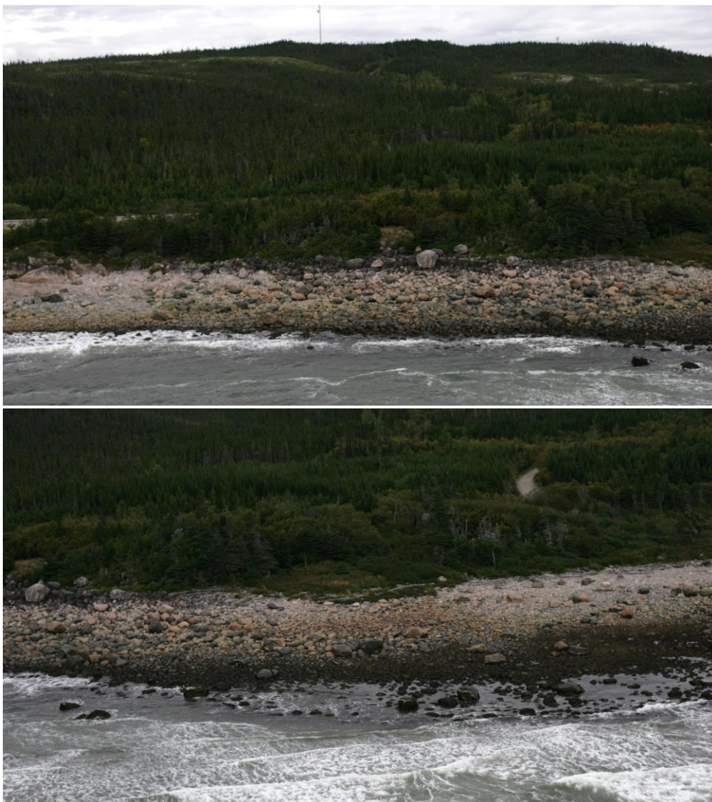
Figure 132. BOU001 et 002, vulnérables respectivement d'ici 2060 et 2100 (© LDGIZC – UQAR, septembre 2010)
