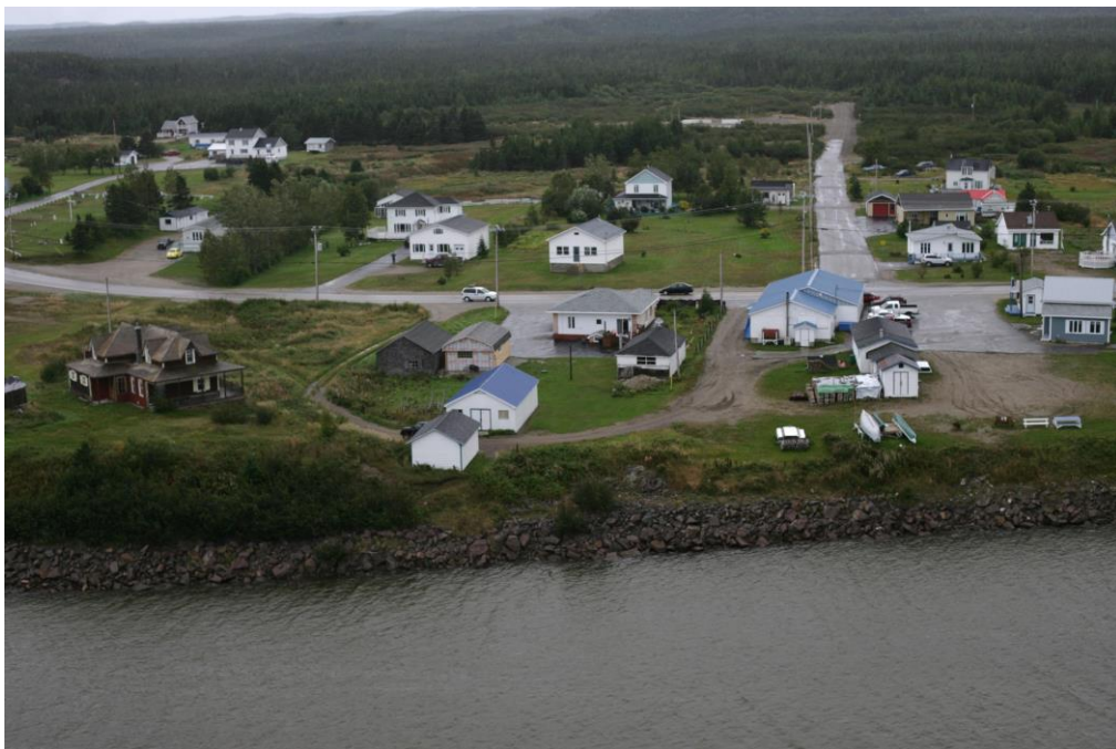
Figure 96. Segments avec une vulnérabilité critique d'ici 2100 – segment RSJ105 (© LDGIZC – UQAR, septembre 2010)
