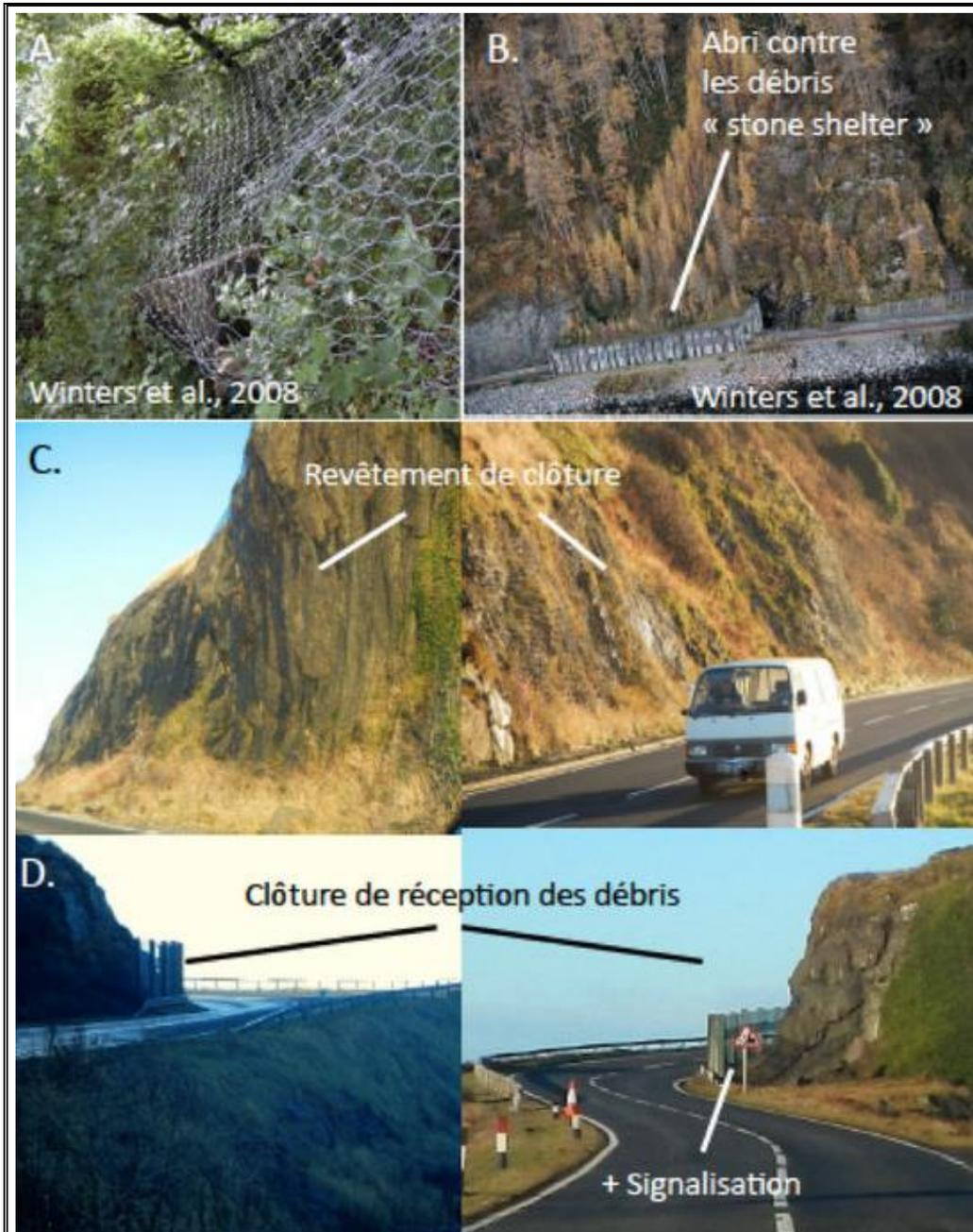
A. Détails de clôture. B. Abris routier contre les débris. C. Revêtement de clôture. D. Clôtures de réception des débris, avec signalisation appropriée. Voir Winter *et al.* (2008) pour d'autres mesures spécifiques aux mouvements de terrain et à leur gestion en milieu routier. À noter que plusieurs exemples dans ce rapport proviennent de la Colombie-Britannique.
