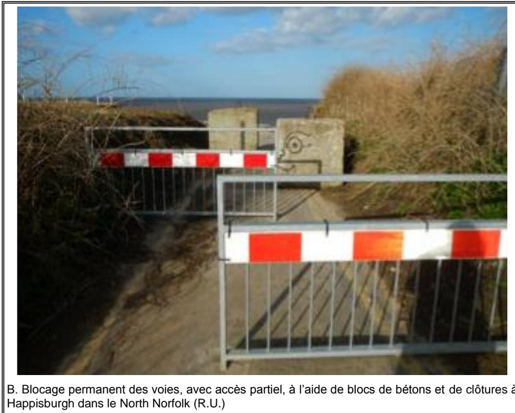
**Stratégie 30. Acceptation d'une perte d'infrastructure.** À l'instar des exemples français et britannique, utiliser des clôtures et des blocs de béton pour limiter ou bloquer complètement l'accès de routes ayant subi des pertes irréversibles et remettre à l'état naturel le site.
