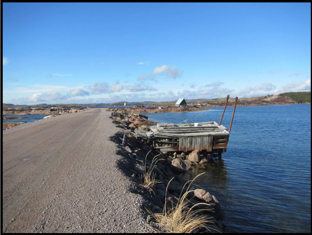
**Figure 6 :** Partie sud du tronçon 2 avec gabions de quai, chaînage 8+642
