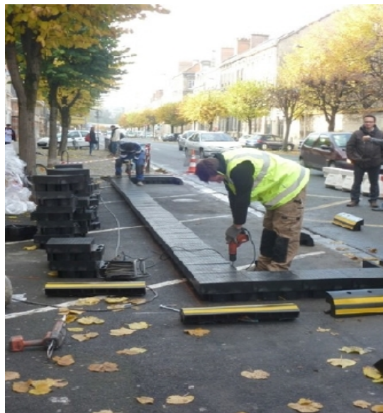
Montage du quai
