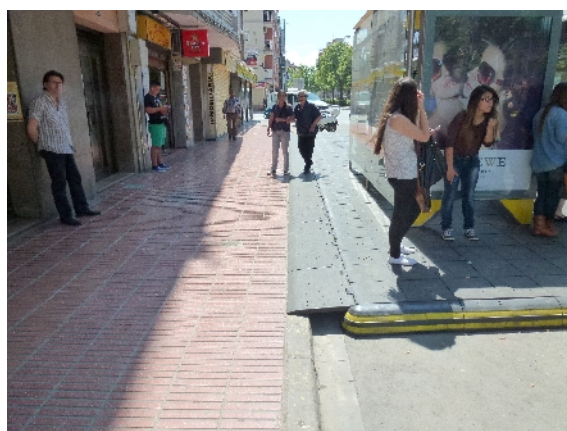
Grilles mobiles de mise à niveau avec le trottoir
