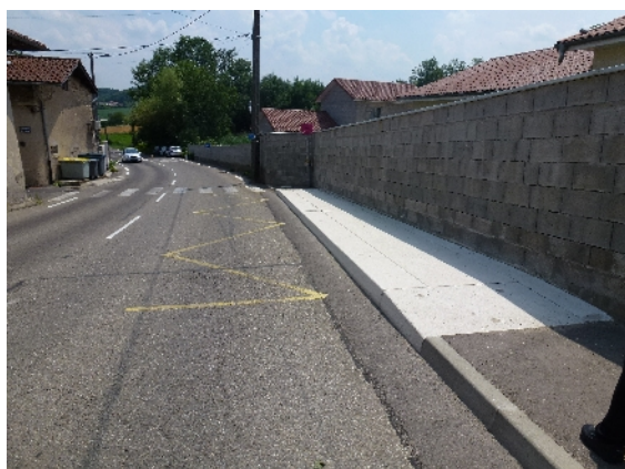
Arrêt dans la continuité du trottoir
