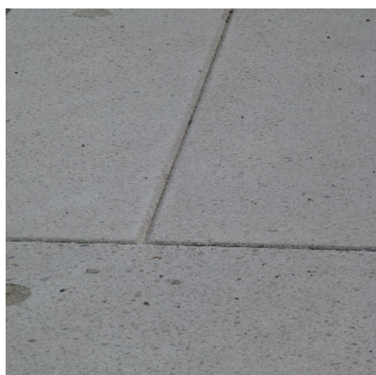
Guide canne intégré aux éléments préfabriqués
