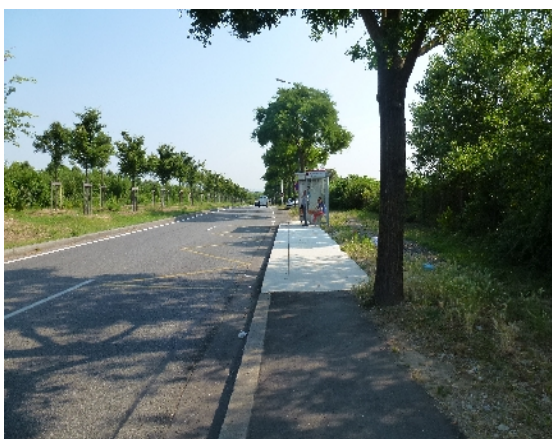
Alignement avec le trottoir existant satisfaisant
