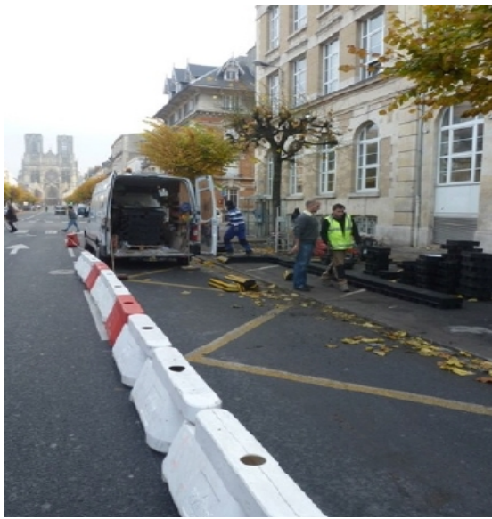
Montage du quai
