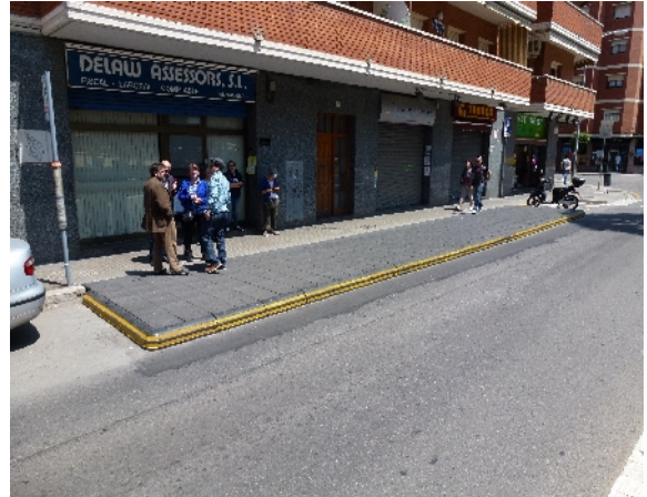
Aménagement du quai de bus modulaire
