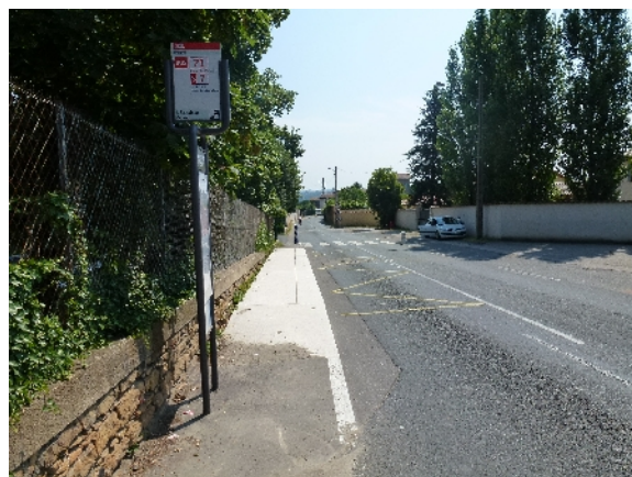
Contraste de la couleur du béton et signalétique mise en place
