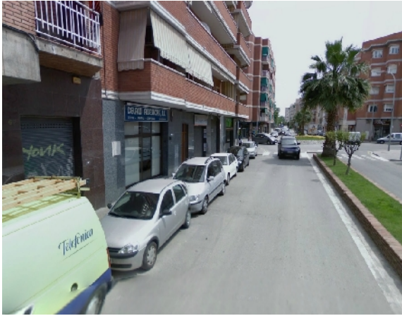
Avant aménagement de l'arrêt de bus
