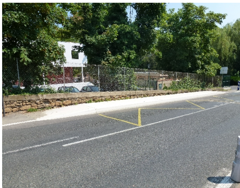
Quai en alignement, en milieu péri-urbain sur le territoire communal de Saint Cyr au Mont d'Or. Il s'agit d'un quai aménagé en ligne. Le quai mesure 18 m de longueur, 1,50 m de largeur avec 2 rampes. Il n'existe pas de continuité piétonne en amont et en aval, mais le quai permet le déploiement d'une rampe d'accès, le rendant accessible pour une personne en fauteuil roulant. Pas de quai accessible en face.
