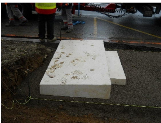
Mise en place de la rampe d'accès
