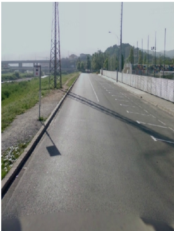
Avant aménagement du quai de bus modulaire
