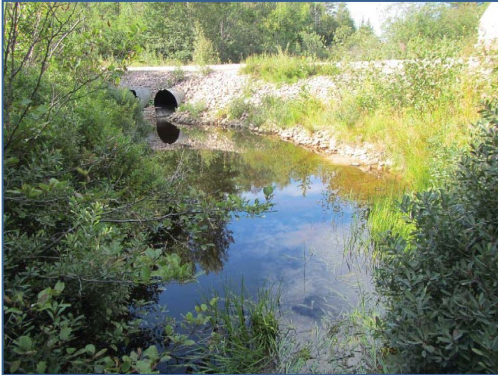
Photo 3 – Ruisseau R01 : Segment PE03
