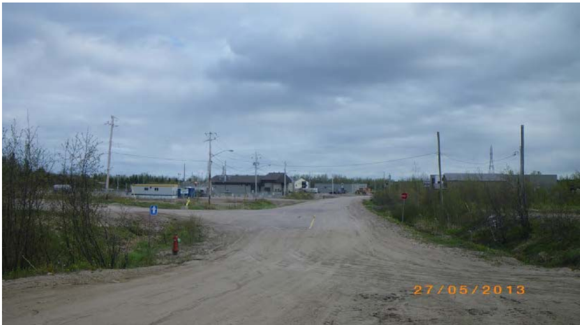
Photo 2 : Vue vers l'est. Entreposage et/ou équipement de distribution d'hydrocarbures et activité désignées à l'Annexe III du RPRT (Distribution Nord)
