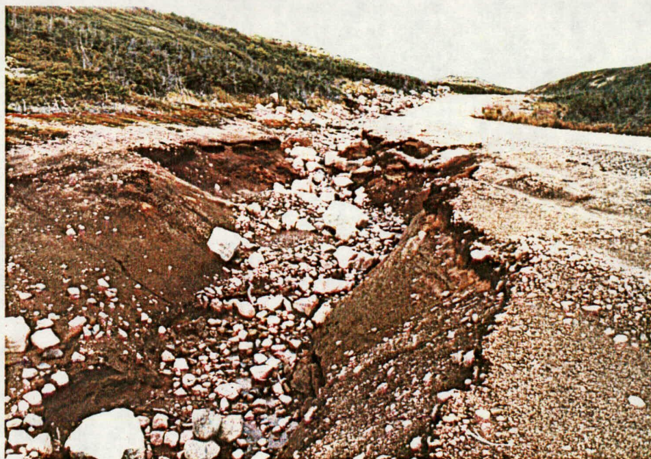
Vue vers le haut de la pente
