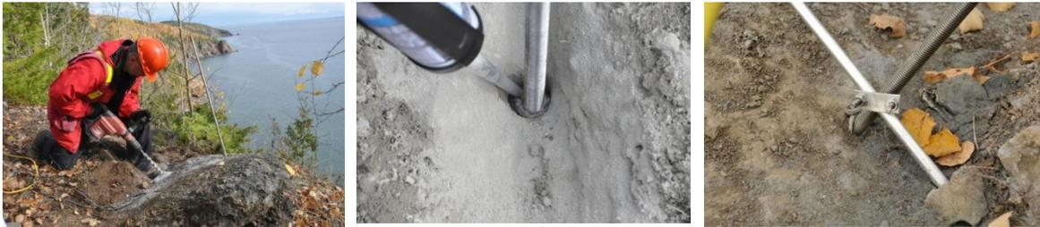
**Figure 6** Installation du système d'ancrage dans le roc.
