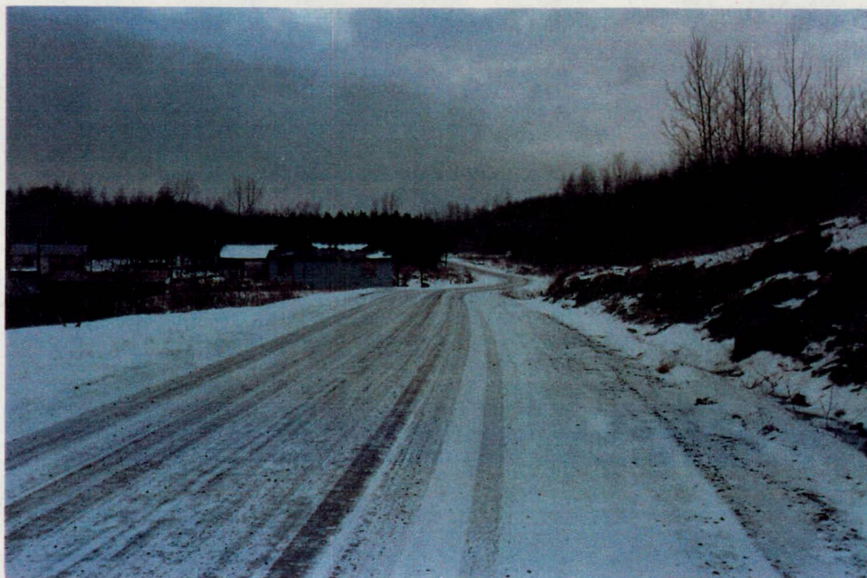
Photo 4 : Alignement de la route, du chaînage 0+440 vers le nord (0+600). Les courbes en "S" seront adoucies et le talus de déblai stabilisé
