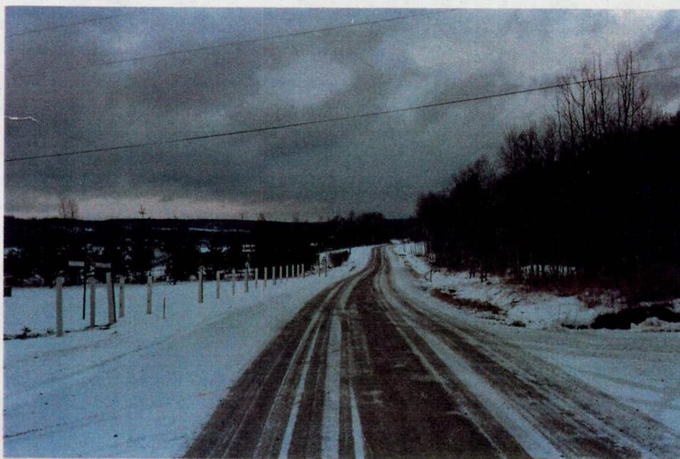
Photo 5 : Alignement de la route, du chaînage 0+900 vers le chaînage 1+300
