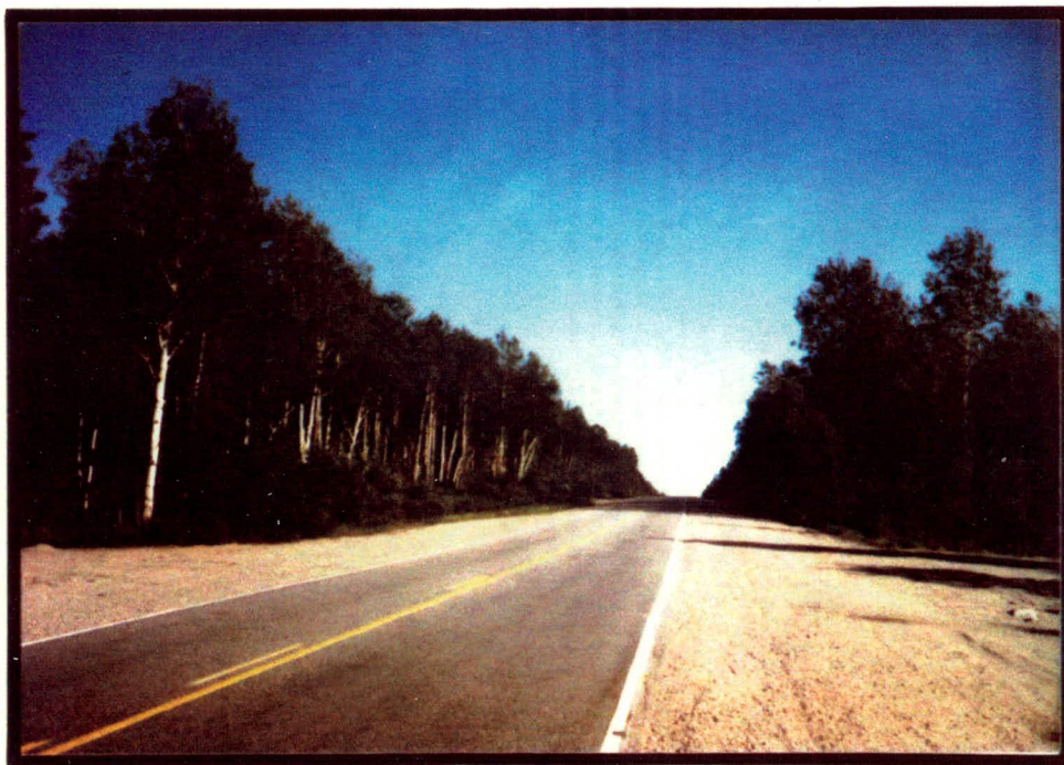
Photo 2: Km 12,5 ( Vue en direction sud )
