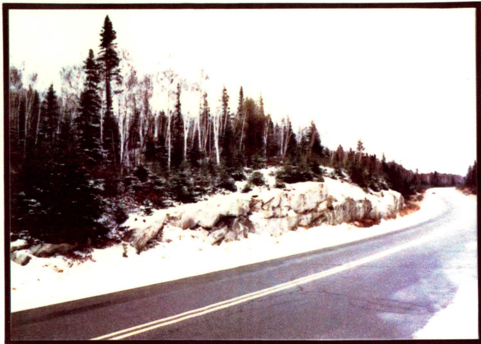
Photo 3 : Km 14,3 ( Vue en direction sud )
