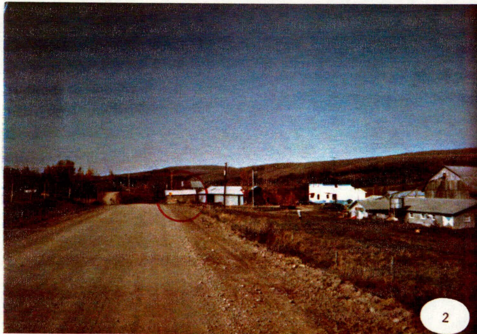
Garage qui sera exproprié au chaînage 2+928
