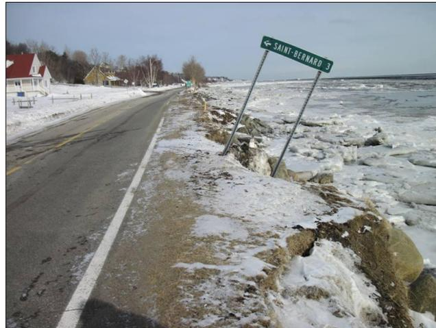
**Photo 2.1 Dommages causés à la côte et aux ouvrages de protection lors des tempêtes de l'hiver 2009-2010, secteur du chemin des Coudriers**
