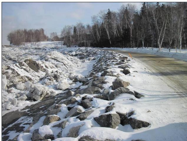
**Photo 1.1 Travaux d'enrochement réalisés d'urgence en décembre 2009, secteur du chemin de la Bourroche**
