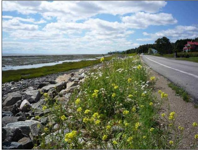
**Photo 3.1 Secteurs 3 et 4 – Chemin des Coudriers. Enrochements réalisés en 2007 par le MTQ et plantation dans le haut de l'ouvrage**
