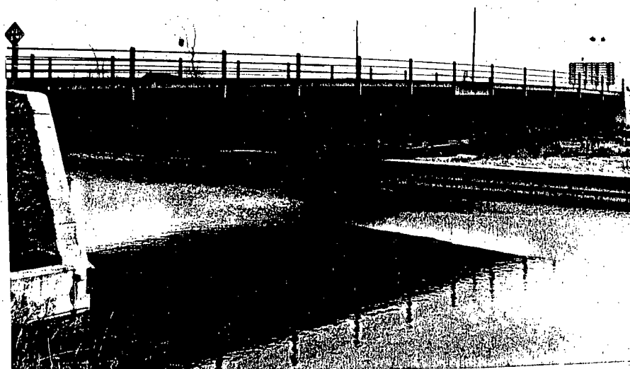
Pont tournant de la Route 201 à remettre en service
