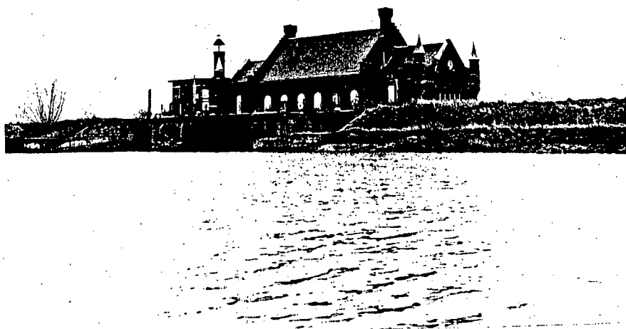
Ancienne centrale Hydro-électrique maintenant désaffectée
