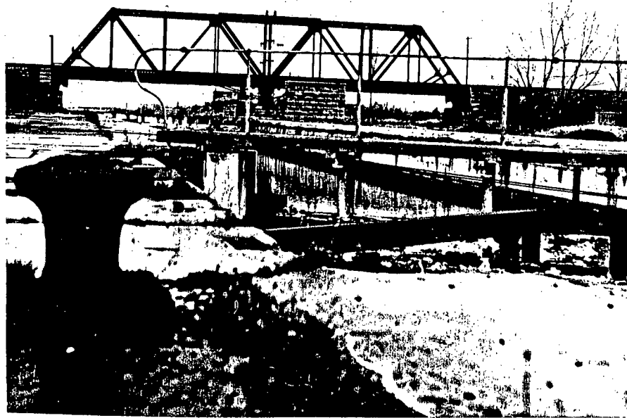
Pont tournant du C.N. à remettre en service
