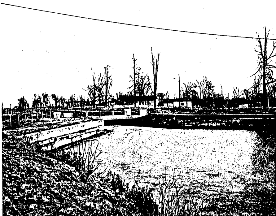
Pont sur l'entrée de l'écluse No 3, à Pointe-des-Cascades.
