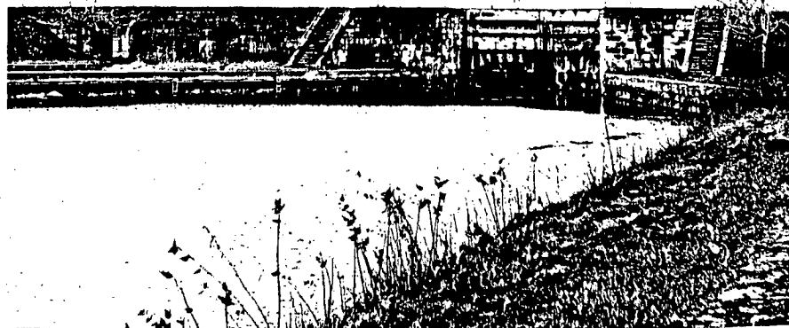
Aspect général d'une écluse (Ecluse No 4)
