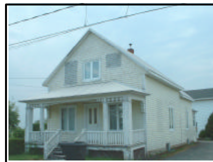
Figure 34 : Maison sise au 18 rue Saint-André (photo : Inventaire architectural de La Mitis, CLD de La Mitis).
