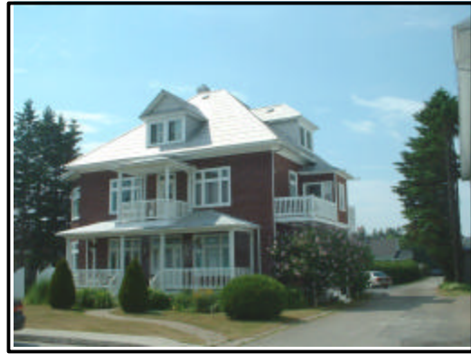
Figure 32 : Maison située au 28 de la rue Saint-Rémi (photo : Inventaire architectural de La Mitis, CLD de La Mitis).
