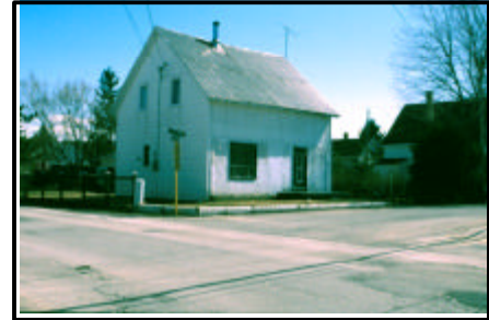
Figure 21 : L'ancienne boulangerie Ross au coin des rues Fournier et Saint-Camille (photo : Jacques Guimont).
