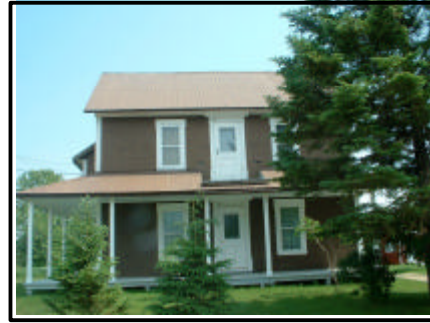
Figure 36 : Maison située au 15 rue Saint-André (photo : Inventaire architectural de La Mitis, CLD de La Mitis).
