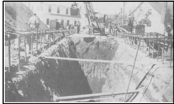
Figure 13 : Une tranchée pour la pose du système d'égout en 1946. Les tranchées avaient parfois de 18 à 20 pieds de profondeur (En collaboration, Op. cit. , p. 134 ; provenance : Mme Charles Bédard).
