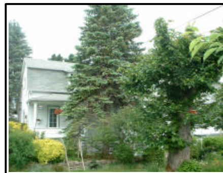
Figure 30 : Maison située au 48 de la rue de l'Église (photo : Inventaire architectural de La Mitis, CLD de La Mitis).
