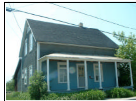
Figure 40 : Maison située au 79 rue de l'Église (photo : Inventaire architectural de La Mitis, CLD de La Mitis).
