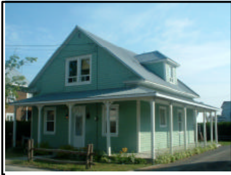
Figure 31 : Maison sise au 28 de la rue de l'Église (photo : Inventaire architectural de La Mitis, CLD de La Mitis).
