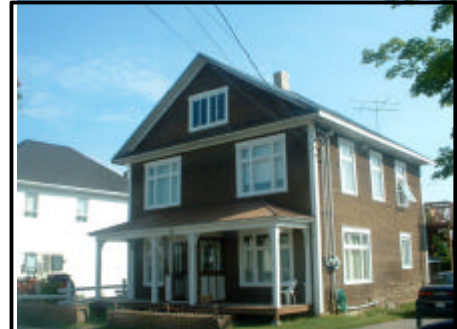
Figure 28 : Maison sise au 26 rue de l'Église construite en 1880 (photo : Inventaire architectural de La Mitis, CLD de La Mitis).
