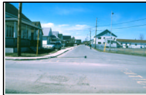
Figure 46 : La rue du Couvent en direction ouest, depuis la rue Saint-Camille (photo : Jacques Guimont).
