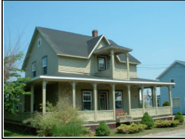
Figure 41 : Maison située au 88 rue de l'Église (photo : Inventaire architectural de La Mitis, CLD de La Mitis).
