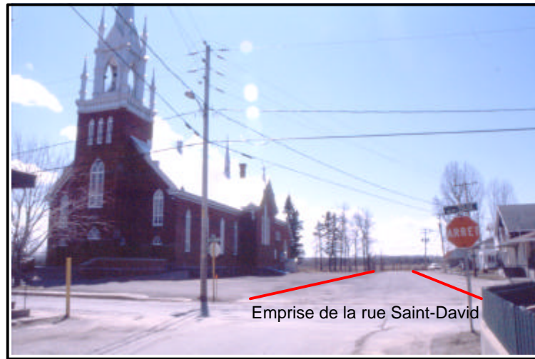
Figure 51 : Emplacement de la rue Saint-David à proximité de l'Église (photo : Jacques Guimont).
