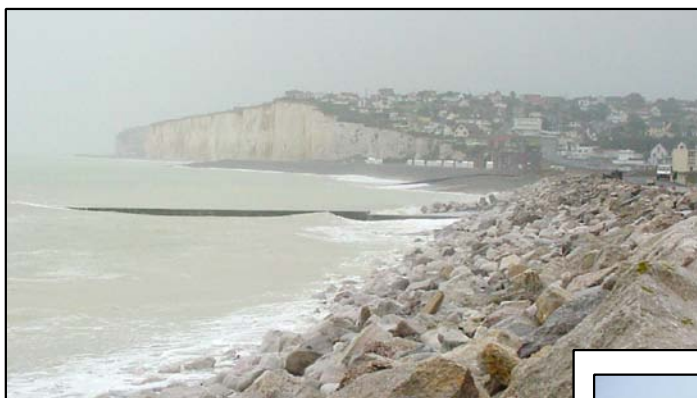
Enrochements à Criel-sur-Mer (76)
