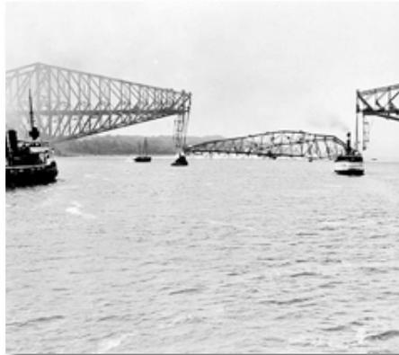
Figure 3. Effondrement du pont cantilever de Québec (QC), 1916<sup>4</sup>
