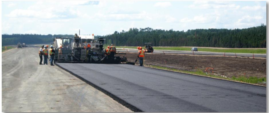
Figure 3. Pavage d'asphalte sur la route 63 à quatre voies, au nord de Wandering River (Alberta) en 2012
