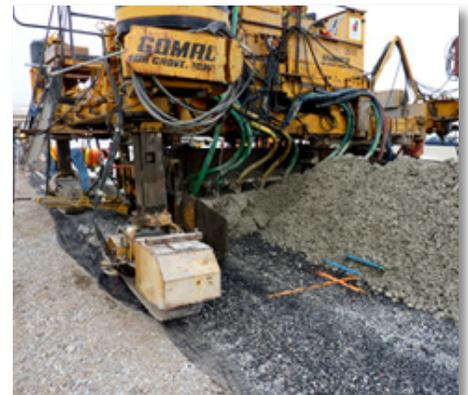
Figure 4. Chaussée de béton sur la route 401 en 2010
