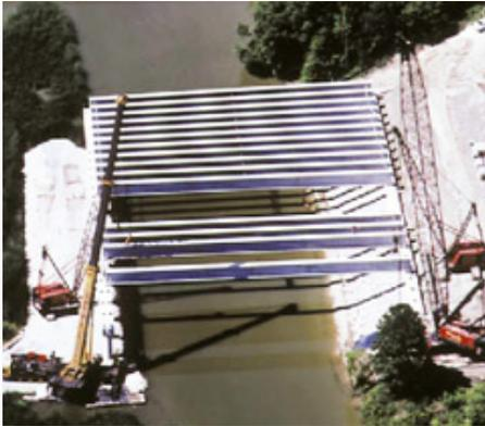
Figure 5. Pont de la route 407 enjambant la rivière Humber, à Toronto. Après avoir été mises en place, les poutres de béton préfabriqué, mises en tension pour la manutention, ont été constamment post-contraintes d'une culée à l'autre pour assurer l'efficacité de la structure.
