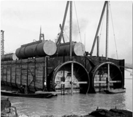
Figure 9. Tunnel Detroit-Windsor lors de sa construction<sup>8</sup>
