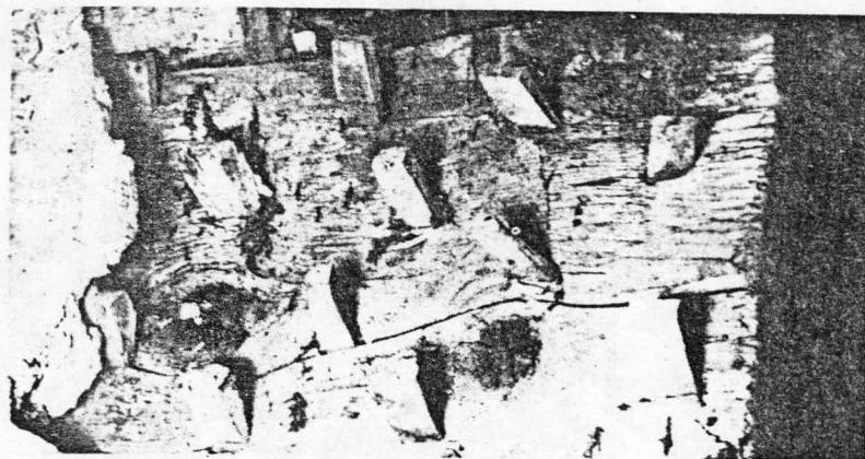
Le picots de chevilletes servira au XVIIIe et au XIXe siècles à retenir le crépi sur les murs. Des chevilles de bois franc de 2" de longueur seront plantées dans les madriers ou les pièces de cèdre (bois mou) soit en quinconce, soit en ligne, soit en désordre, de manière à bien soutenir le revêtement. Pour offrir une meilleure résistance, elles seront piquées obliquement. Remarquer aussi sur cette image l'étaupe (partie la plus grossière de la filasse de lin ou de chanvre) qui sert à boucher les interstices entre les pièces de bois. Ce sont là deux procédés qui se vérifient dans plus d'une maison rurale québécoise des siècles passés.
