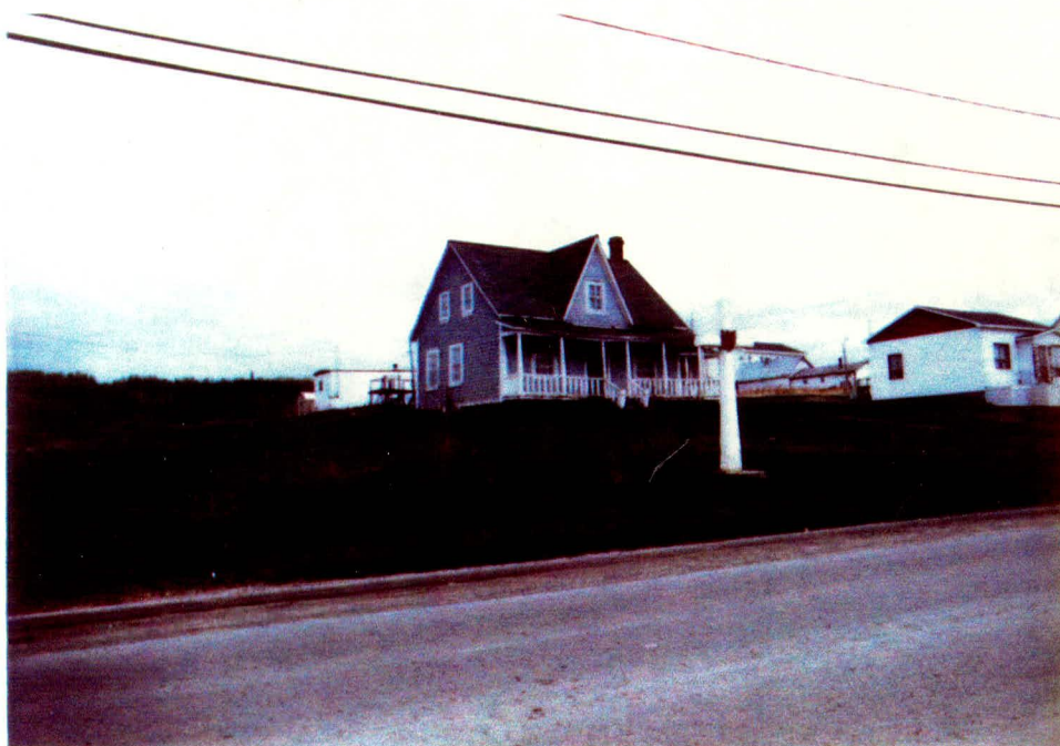
PHOTO 5 Résidence de tradition vernaculaire états-unienne à pignons latéraux avec galbe à l'avant
