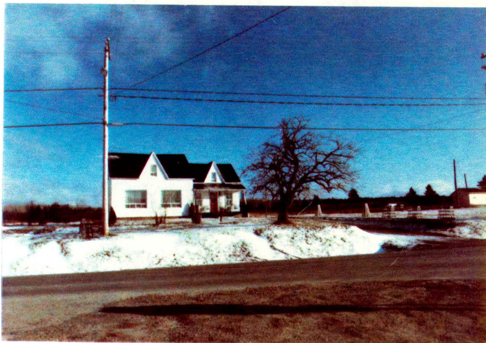
PHOTO 7 Résidence de tradition vernaculaire états-unienne à pignons latéraux avec galbe à l'avant
