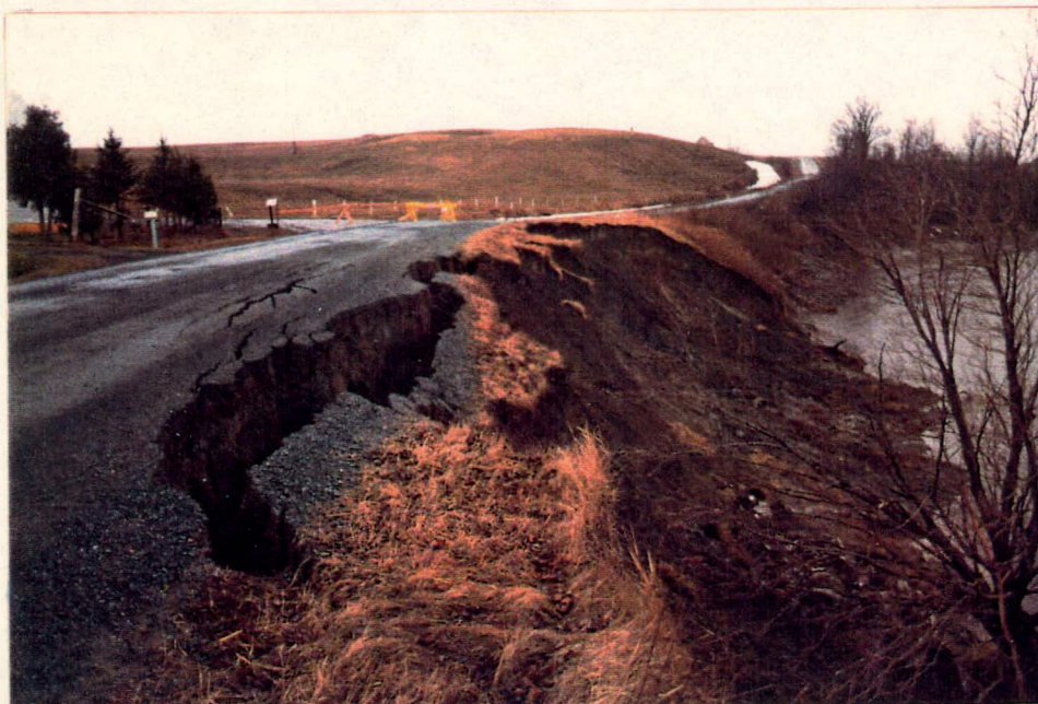
No 3: Chainage 1+222 vers l'ouest; 11 avril 86.
