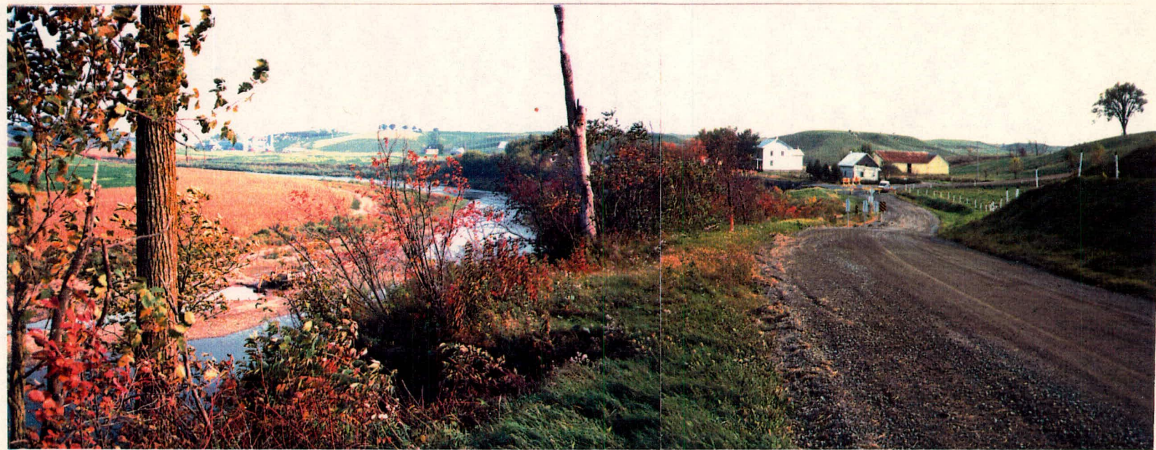
No 8: Chainage 1+015 vers l'est; 29 sept. 87.
