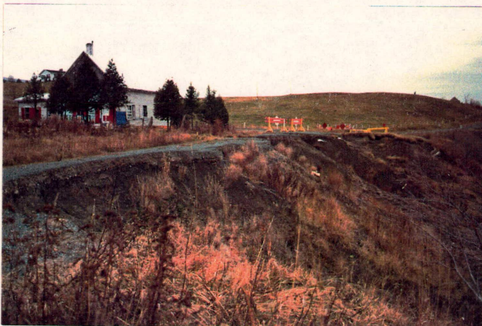
No 10: Chainage 1+245 vers le nord-ouest; 25 nov. 87.
