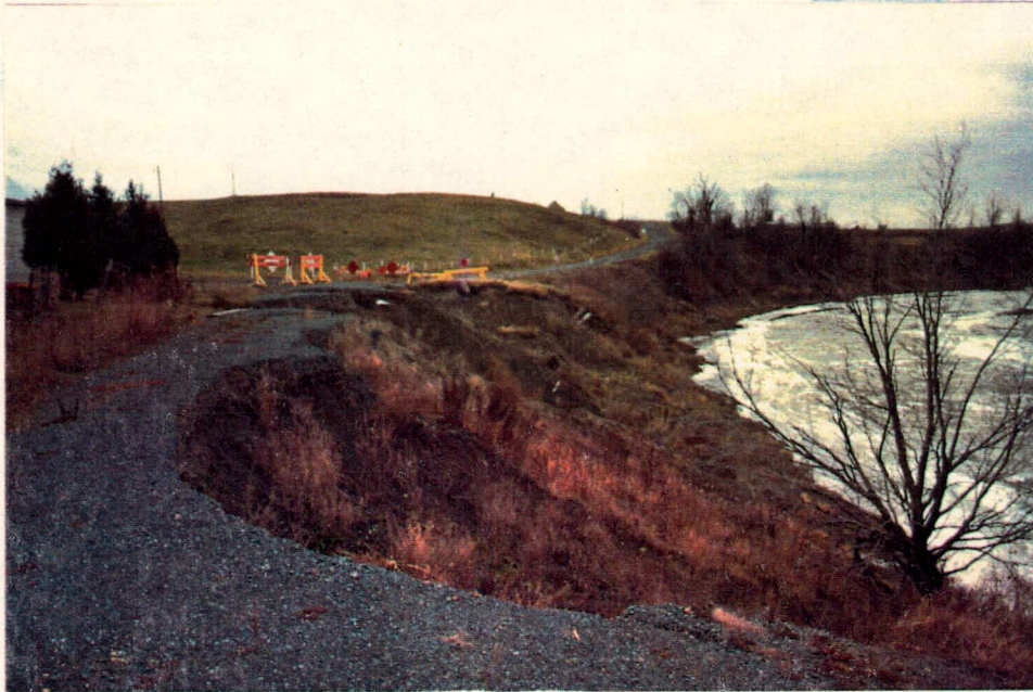
No 11: Chainage 1+242 vers le nord-ouest; 25 nov. 87.
