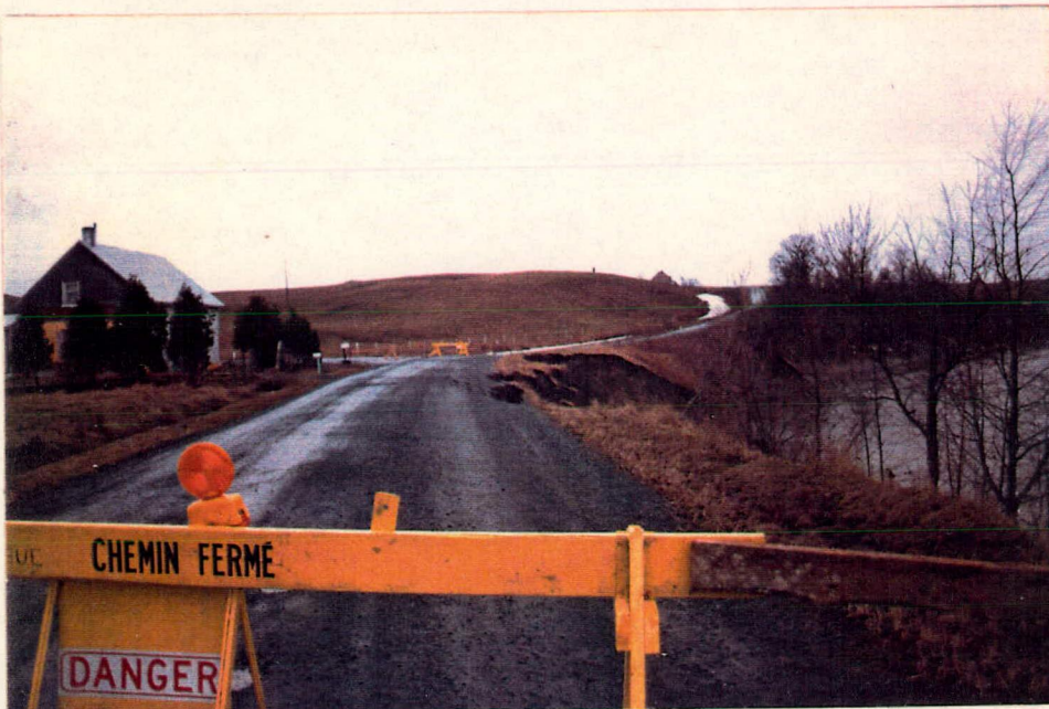
No 2: Chainage 1+240 vers l'ouest; 4 avril 86.
