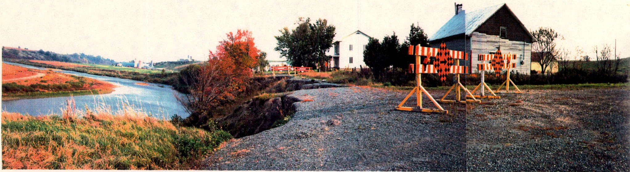
No 7: Chainage 1+175 vers l'est; 29 sept. 87.
