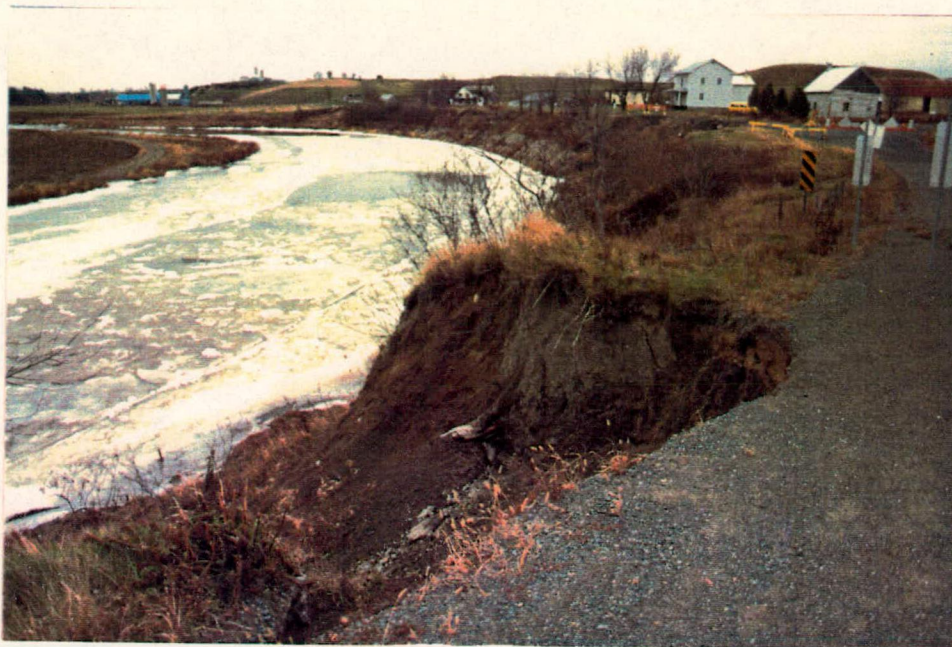
No 9: Chainage 1+080 vers l'est; 25 nov. 87.
