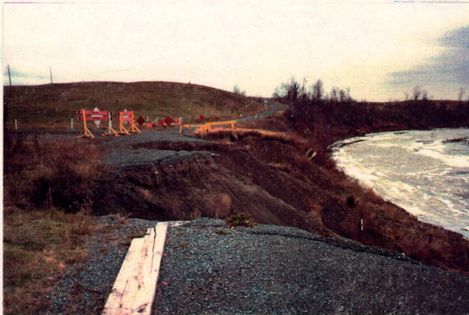
No 12: Chainage 1+218 vers le nord-ouest; 25 nov. 87.
