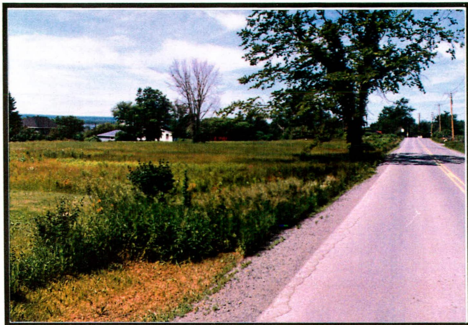
Chemin Mc Connell - Extrémité ouest Vue vers l'ouest
