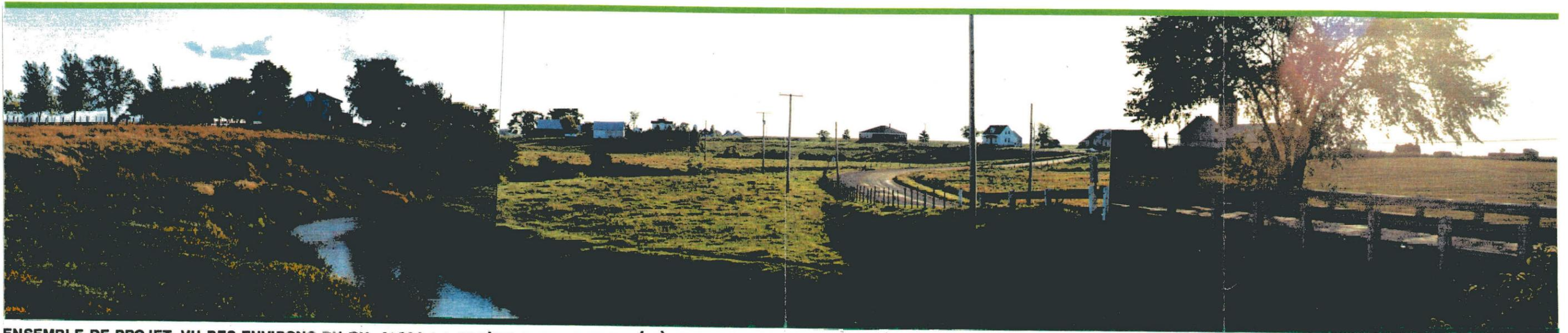
**ENSEMBLE DE PROJET, VU DES ENVIRONS DU CH. 4+600. LA RIVIÈRE SERA REDRESSÉE À GAUCHE DE LA LIGNE (BELL HYDRO); LA ROUTE 226 SERA RÉALIGNÉE À DROITE DE CETTE LIGNE.**
