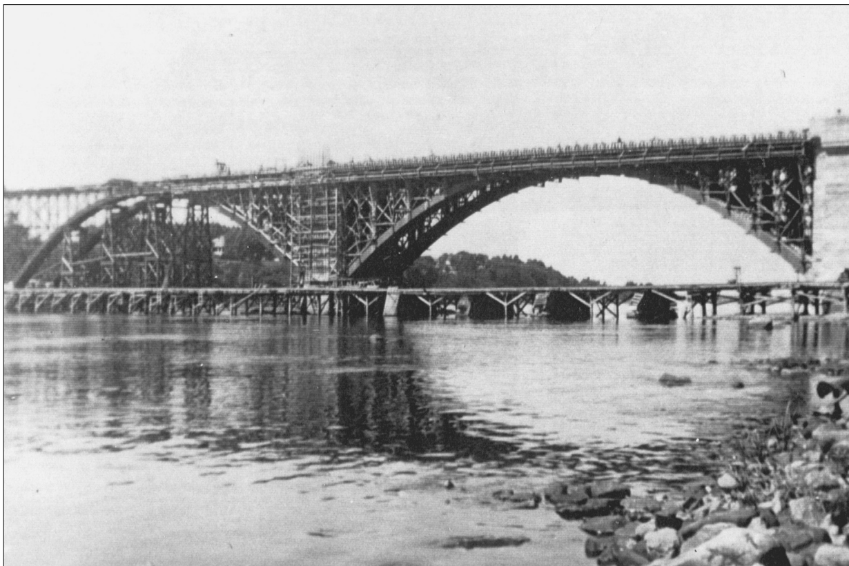
Construction pont Pie-IX en 1937 Photo collection Marie-Rose Moineau-Rougeau de Montréal-Nord
