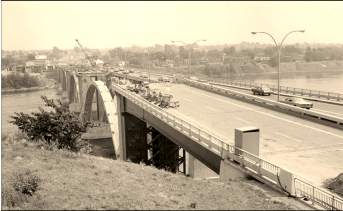
Travaux préliminaires, en vue de la reconstruction de la voie Sud du pont Pie-IX, été 1970
