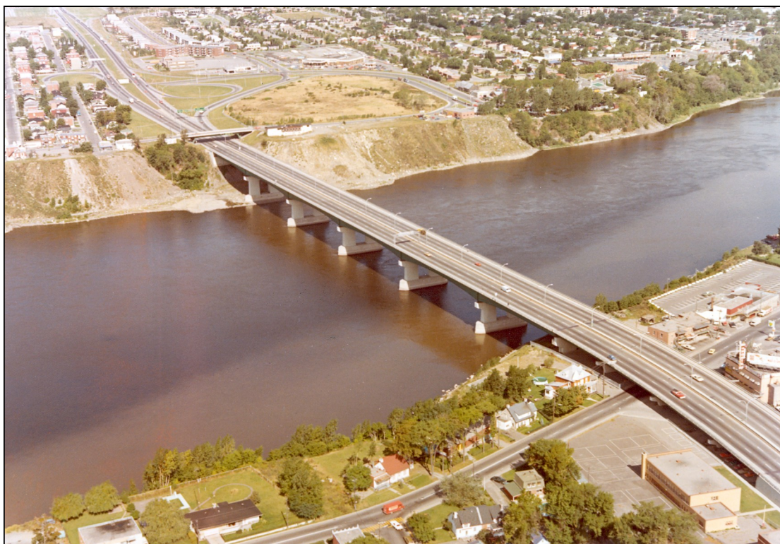
Photos aériennes du pont Pie-IX - (Ministère des transports du Québec)
