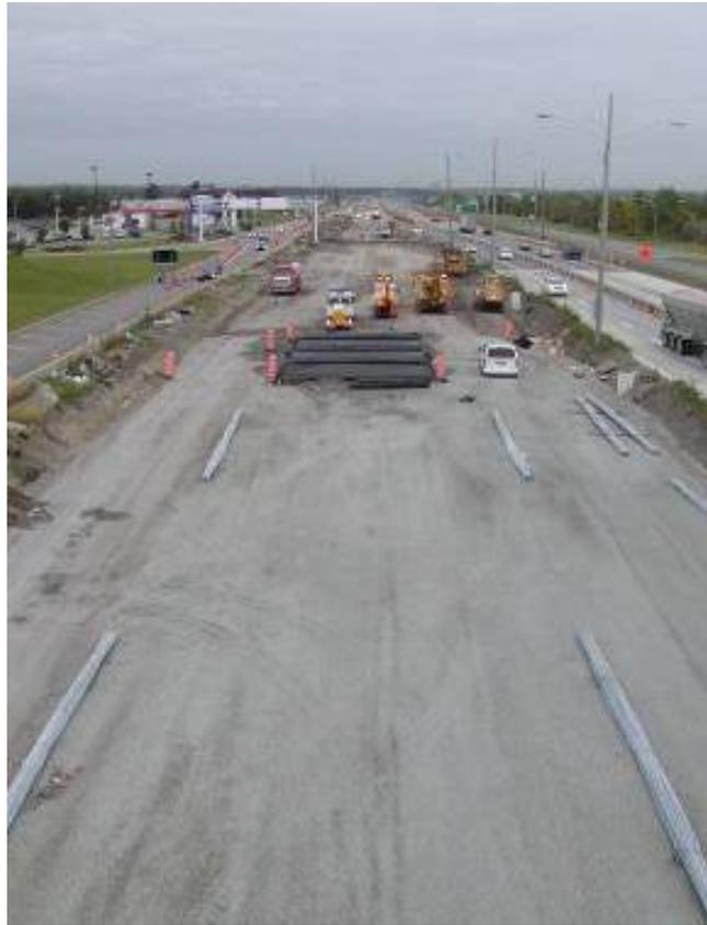
Figure 2-5 : Section étudiée avant la mise en place de l'armature en PRFV
