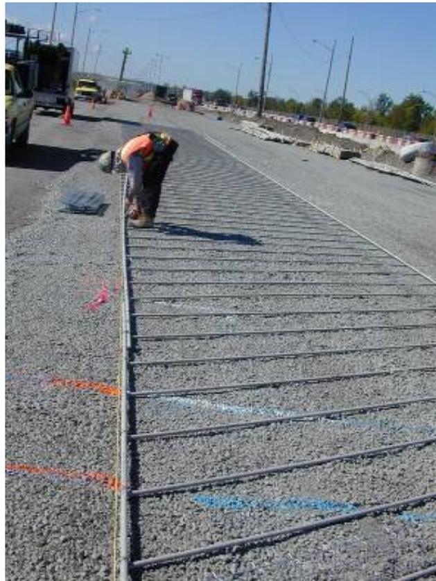
Figure 2-6 : Mise en place des barres d'armature transversales en PRFV (voie centrale)
