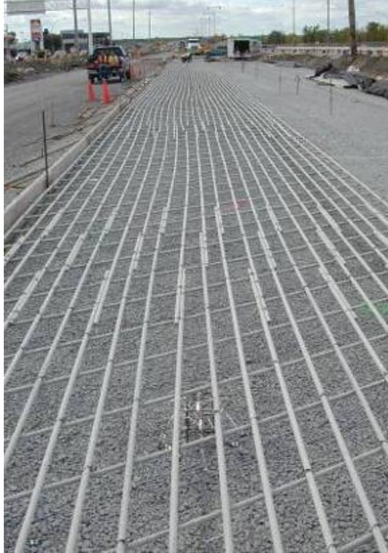
Figure 2-7 : Renforcement de la voie centrale, montrant le recouvrement des barres
