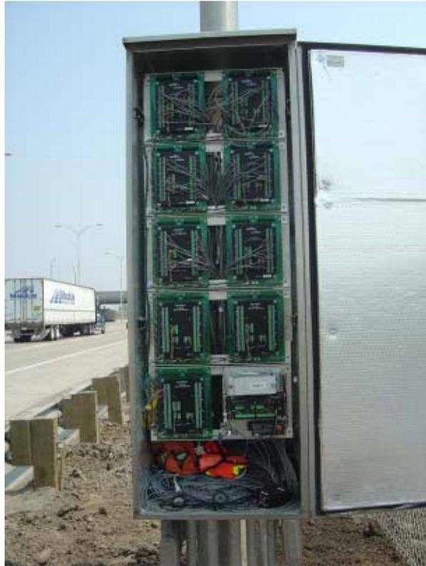
Figure 2-10 : Vue du système d'acquisition installé en bordure de l'autoroute
