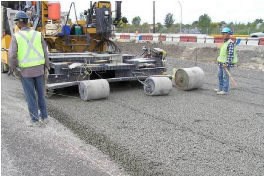
Figure 2-4 : Mise en place de la fondation drainante au-dessus du MG-20
