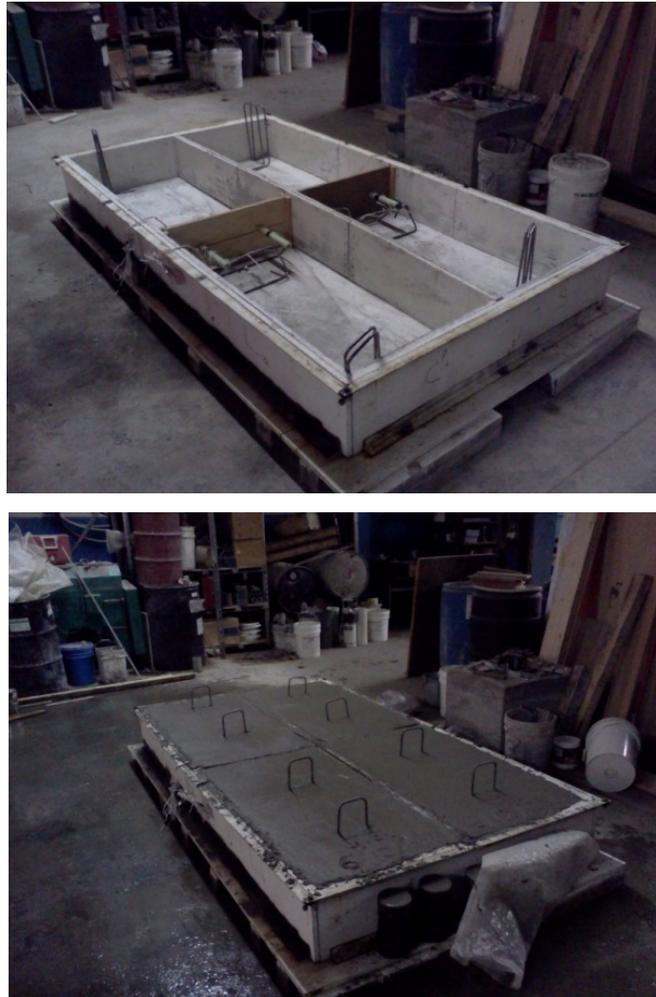
Figure 2.5: Coffrage des dalles jointées, surfaçage et mûrissement
