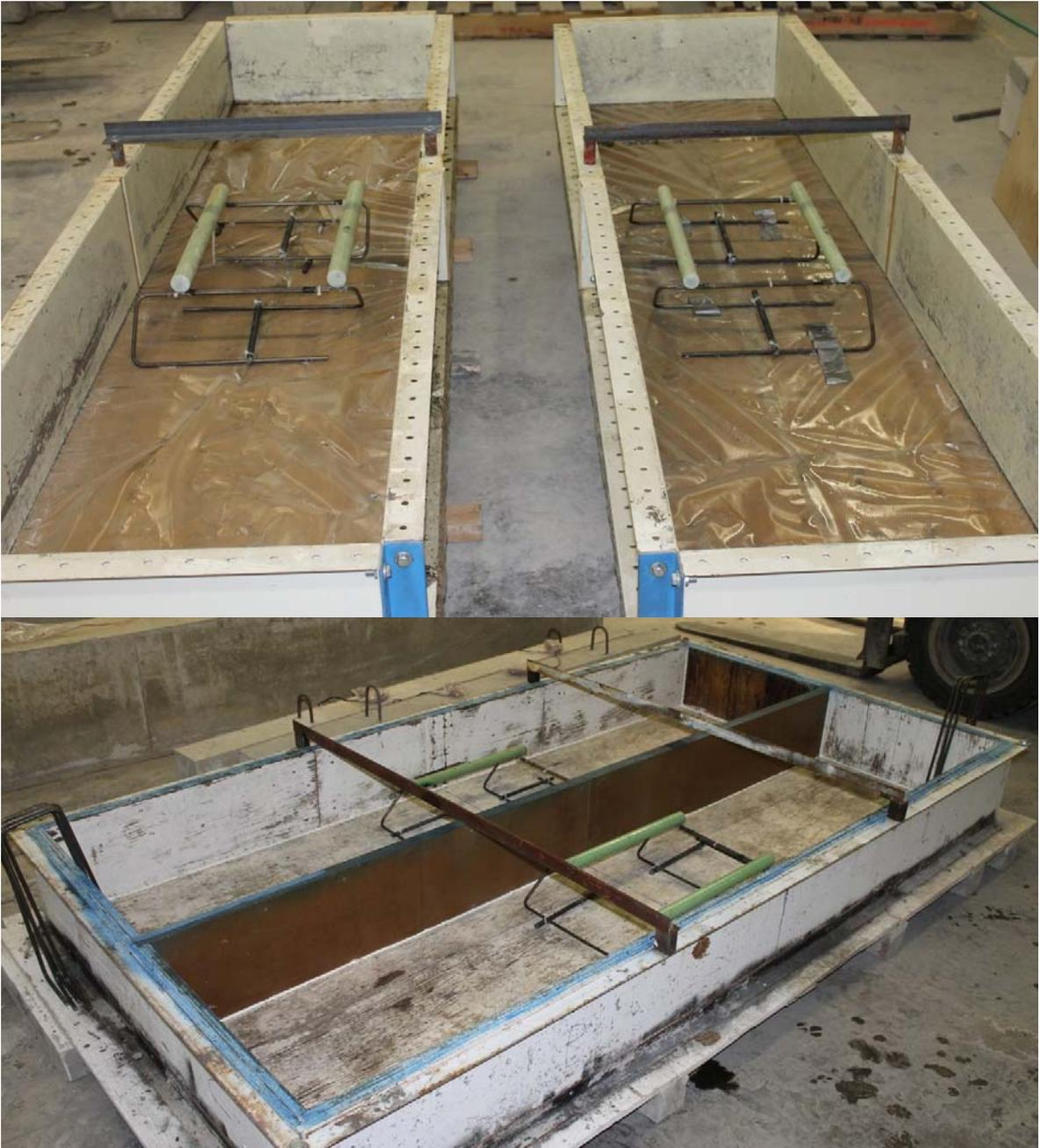
Figure 2.14: Vue des coffrages et de la mise en place des goujons
