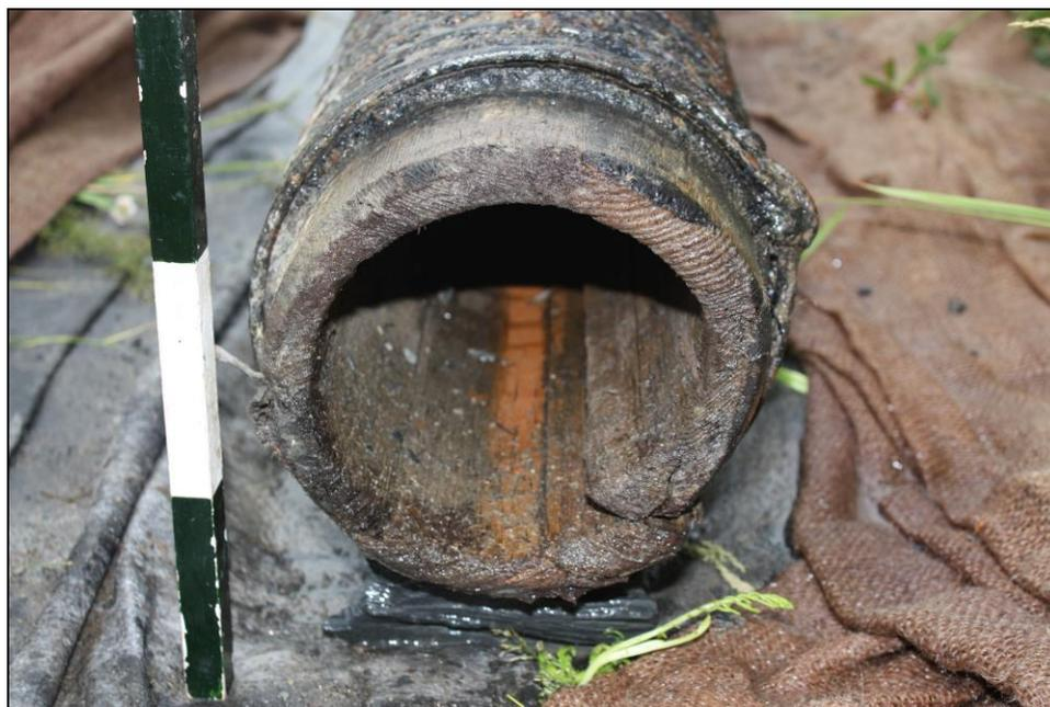
**Photo 9** Détail de l'extrémité de la canalisation assemblée à la manière d'un tonneau, vers le sud (DUCD-13-2012-015)
