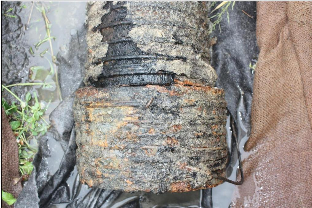
**Photo 10** Collet permettant l'assemblage des sections de la canalisation, en plongée (DUCD-13-2012-008)
