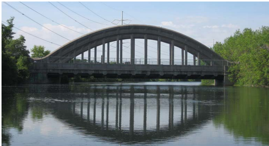
Figure 1. Vue du pont Jolicoeur avant les travaux
