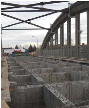
Figure 12. Longerons en décembre 2012 Figure 13. Ouverture de 700 mm dans les longerons Tel qu'illustré à la figure 11, de part et d'autre de la dalle de tablier reconstruite à la première phase des travaux, un espace de 700 mm a été prévu pour chevaucher les barres d'armature. Une partie de la dalle
