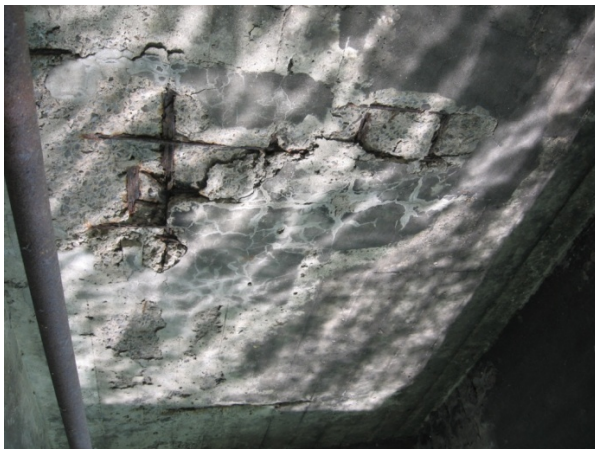
Figure 4. Dommage typique à la dalle de tablier
