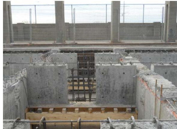
Figure 12. Longerons en décembre 2012 Figure 13. Ouverture de 700 mm dans les longerons Tel qu'illustré à la figure 11, de part et d'autre de la dalle de tablier reconstruite à la première phase des travaux, un espace de 700 mm a été prévu pour chevaucher les barres d'armature. Une partie de la dalle
