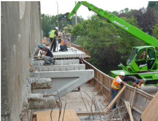
Figure 15. Installation des dalles préfabriquées
