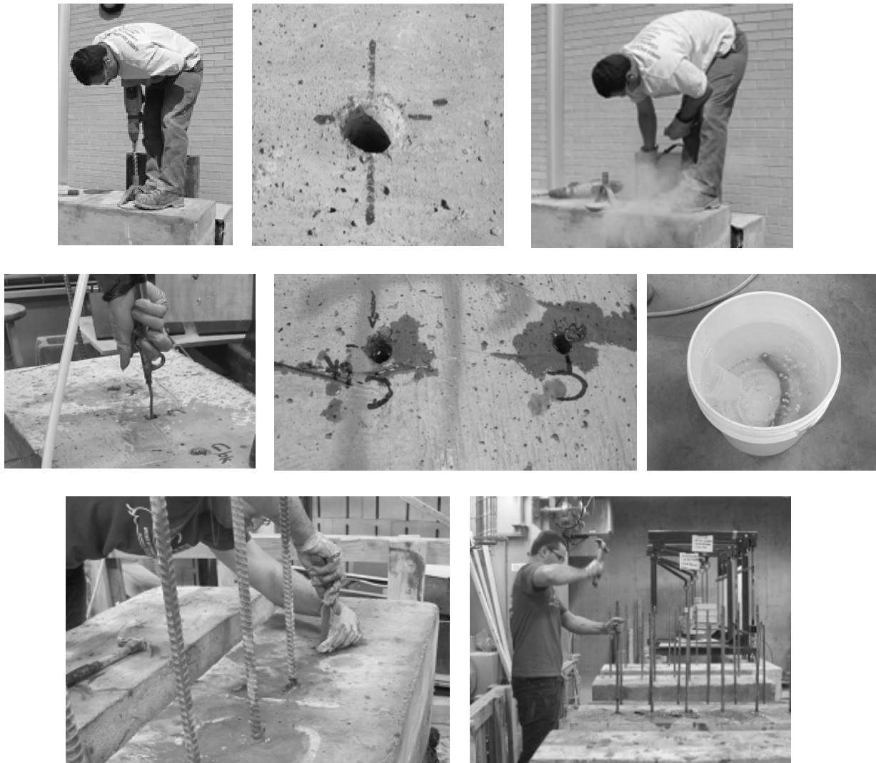
Figure 8- Principales étapes pour le forage et l'installation des ancrages cimentaires
