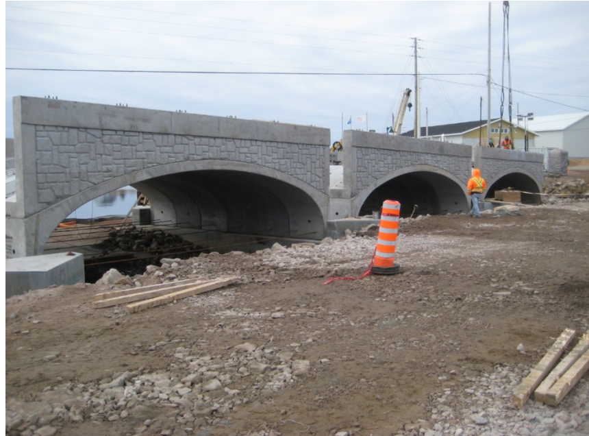
Figure 23 Travées 2 à 4 installées
