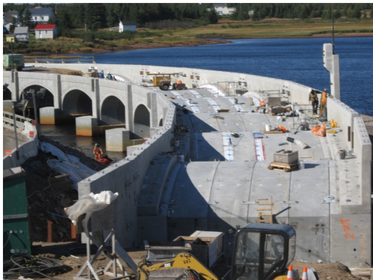
Figure 27 Vue de la courbure du pont
