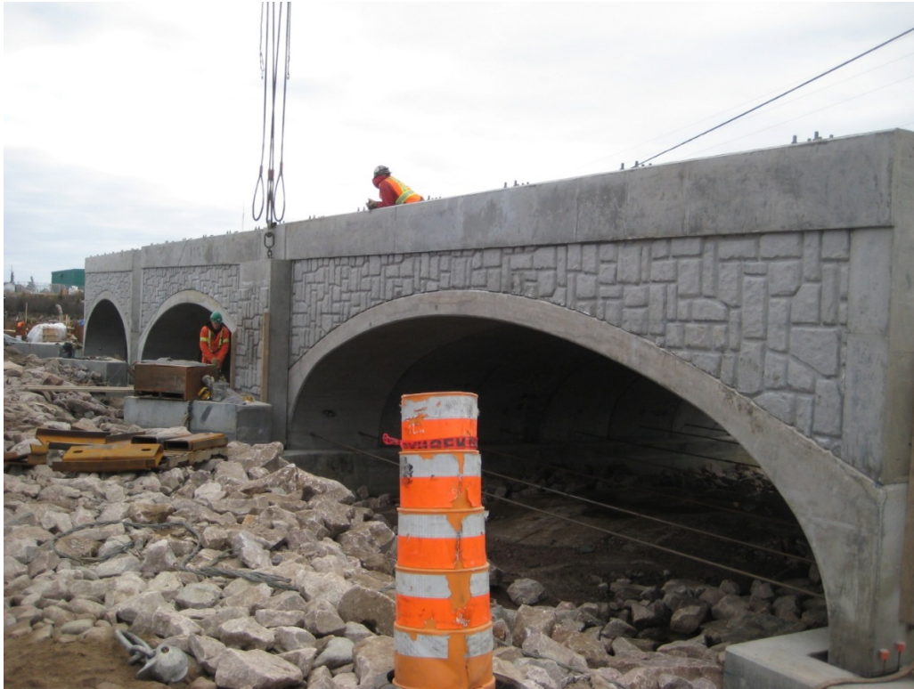
Figure 24 Installation des murs de fermeture
