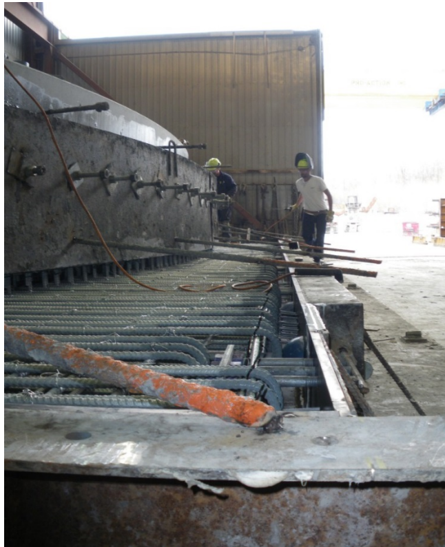
Figure14. Moulage des murs de tête coulés à même l'arche
