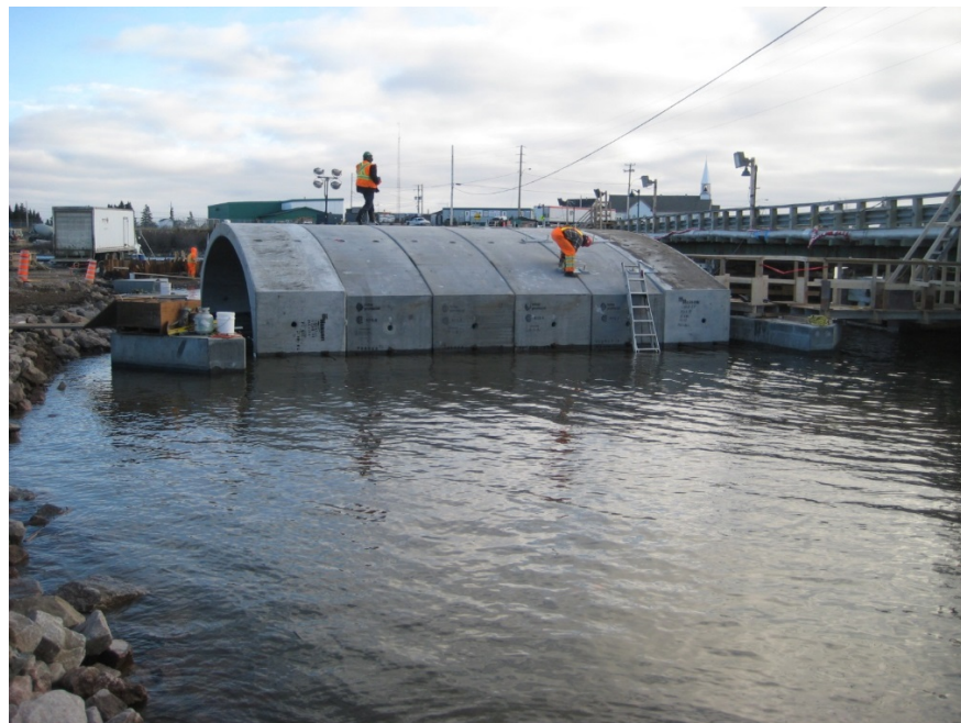
Figure 20 Arches de la deuxième travée installées
