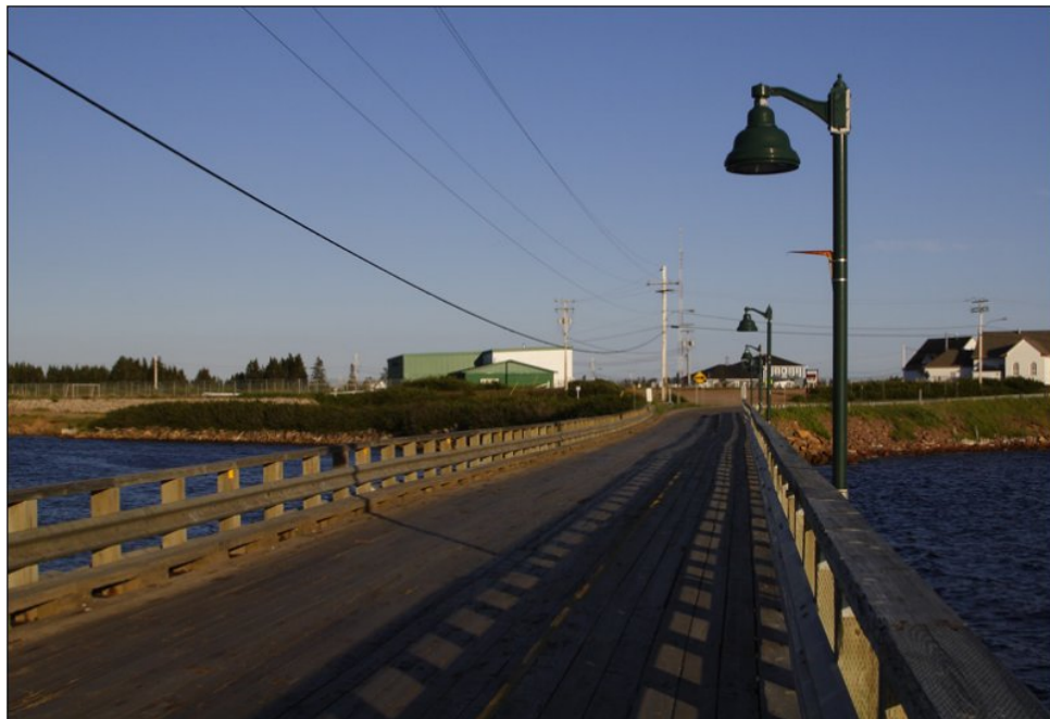
Figure 4. Le tablier en bois du pont existant
