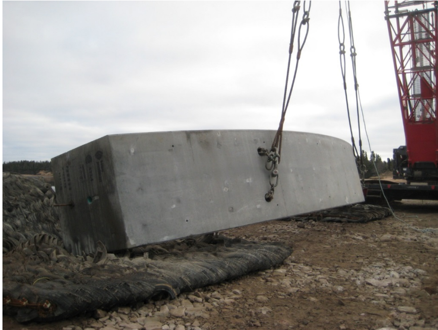
Figure 19 Retournement des arches sur matelas de pneus
