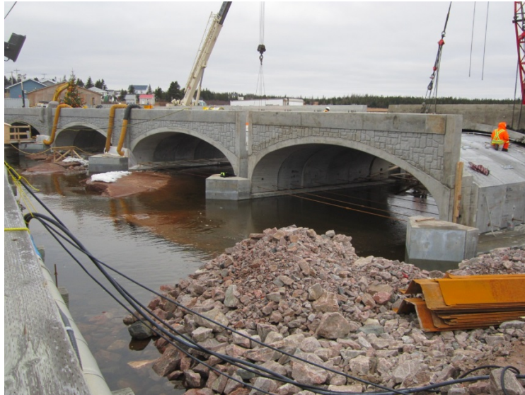
Figure 26 Avancement des travaux à la fin de la première saison
