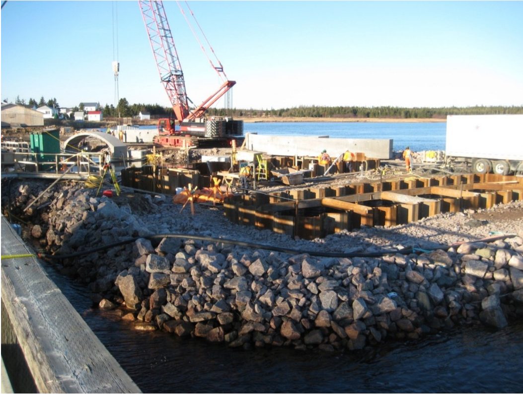
Figure 17 Batardeau et empierrement pour le bétonnage de la pile 5
