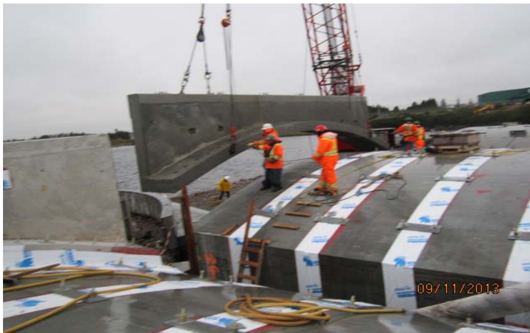
Figure 25 Imperméabilisation des joints
