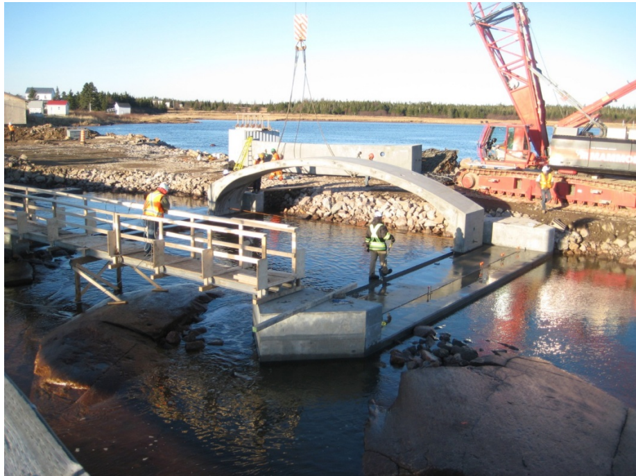
Figure 18 Mise en place des arches à l'axe 2
