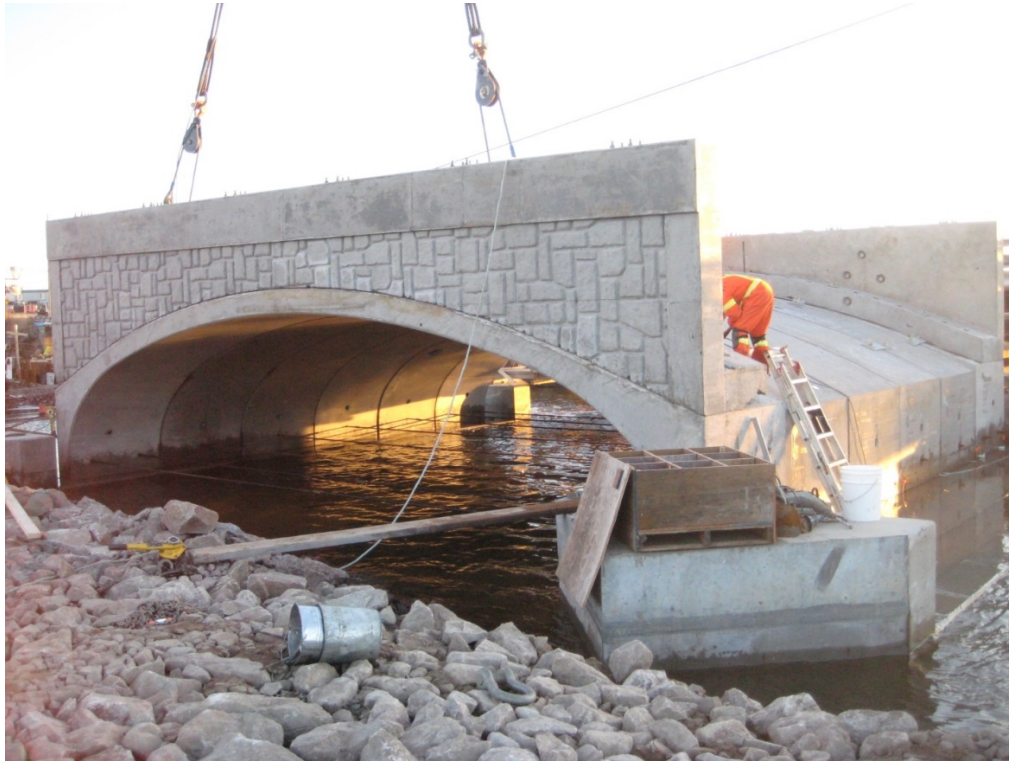
Figure 21 Installation des murs de tête
