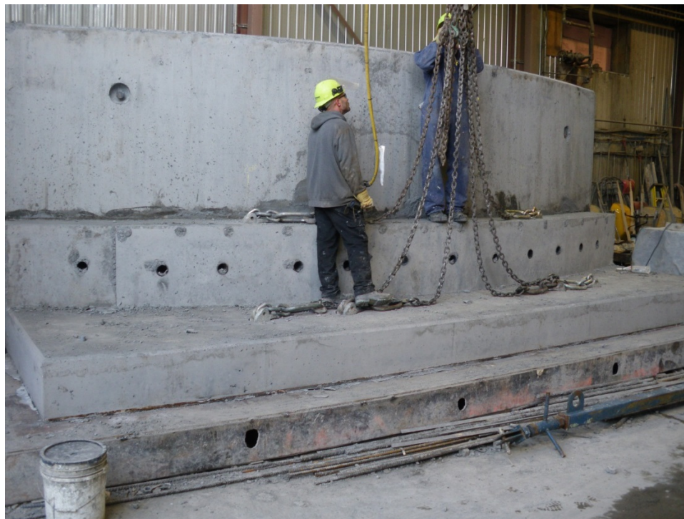
Figure 15 Mur de tête lors du démoulage.
