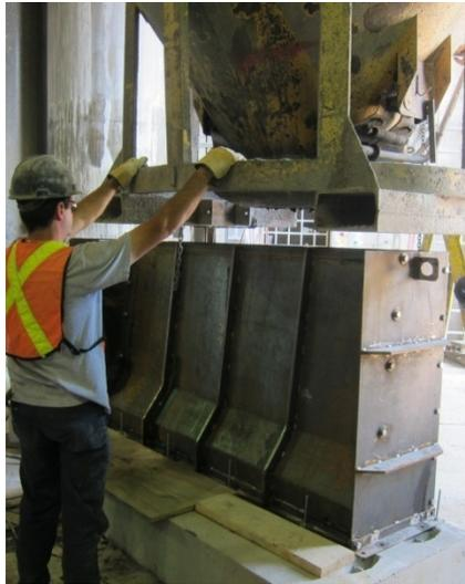
Figure 29 - Coffrage et mise en place du béton dans les parapets MTQ 301
