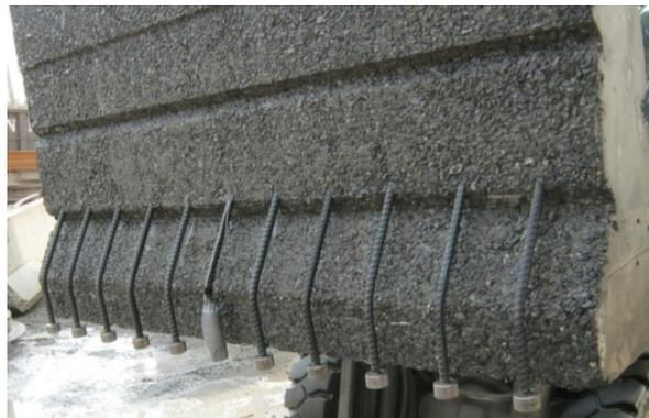
Figure 31 - Cœur du parapet à niche ouverte avec une surface à granulats exposés
