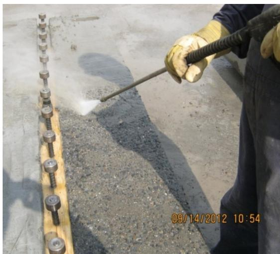
**Figure 28 - Enlèvement d'une mince couche de la dalle pour obtenir une surface en granulats exposés**
