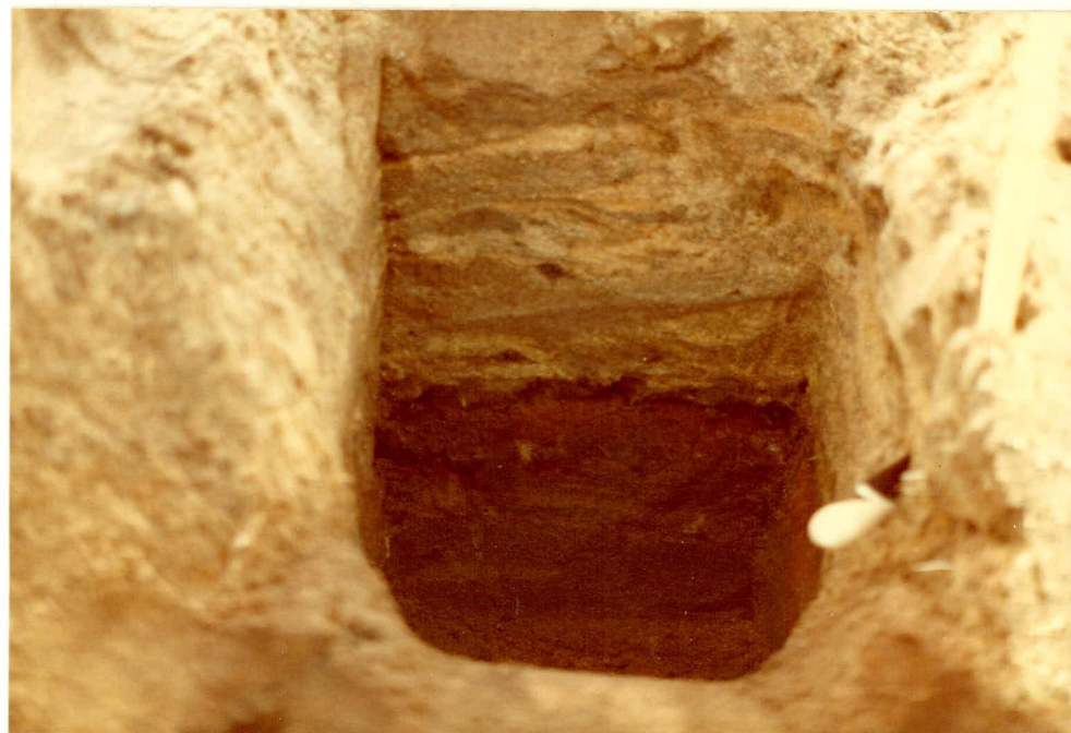
F1-15 Puit "C" 0 + 360 Vue mur Ø
