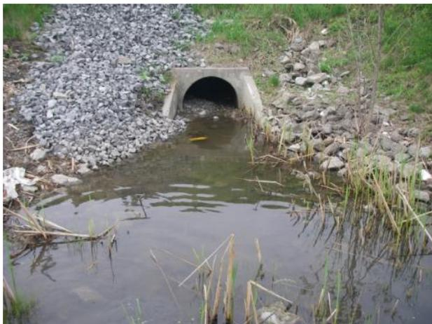
**Photo 1 : L'eau ne circule pas entre les 2 côtés de la route (ruisseau sans nom, côté ouest du pont)**
