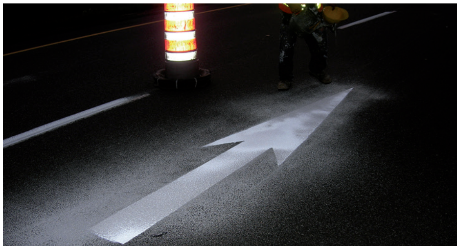
Figure 20 Rétroréflexion problématique d'une flèche
