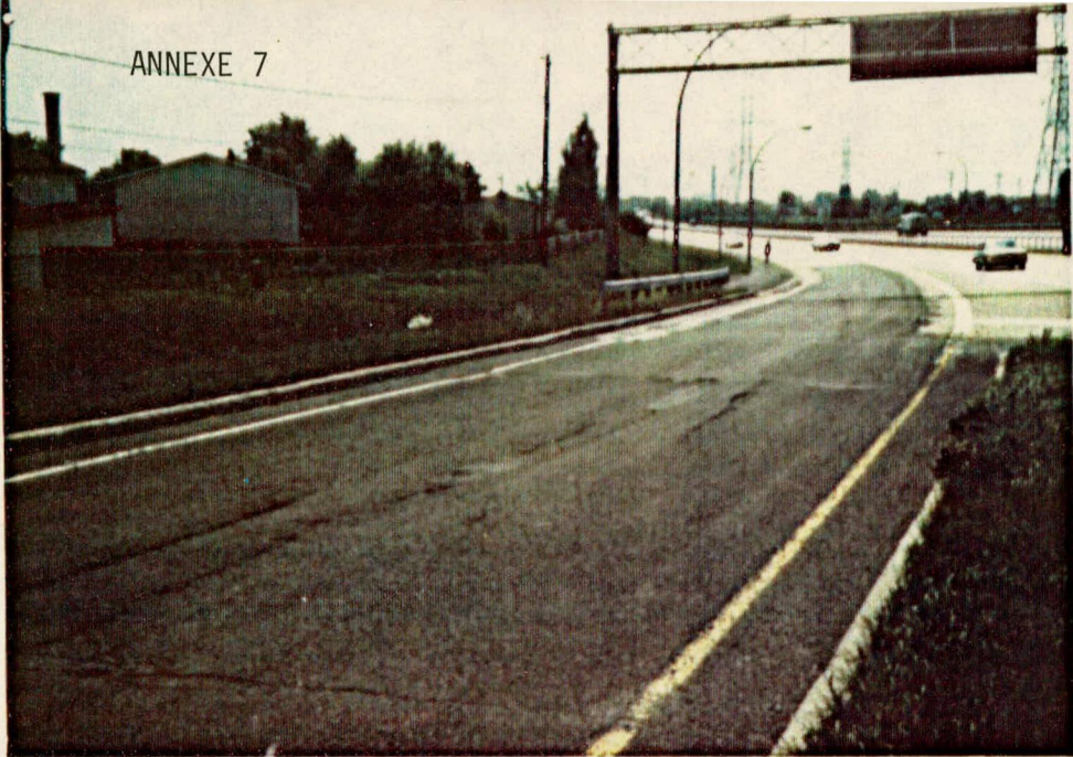
Photo #1 Cour arrière des maisons de la rue Letendre et Evangéline
