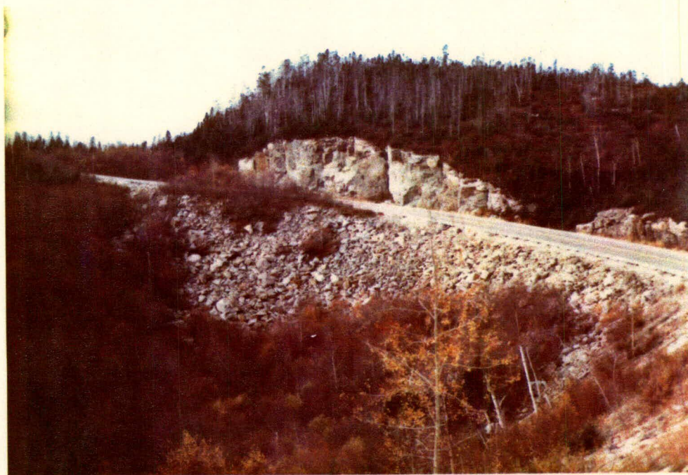
Figure 15 : Vue des coupes de roc et du remblai dans la courbe du tracé actuel
