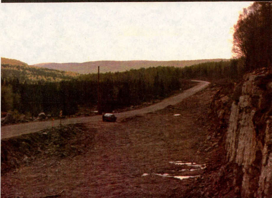
Tronçon 27. Zone dynamitée à 11 600. Vers S.
