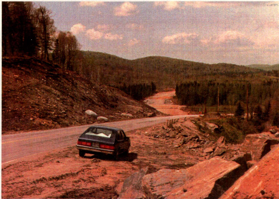
Tronçon 27. Début de la déviation à 2 100. Vers N.
