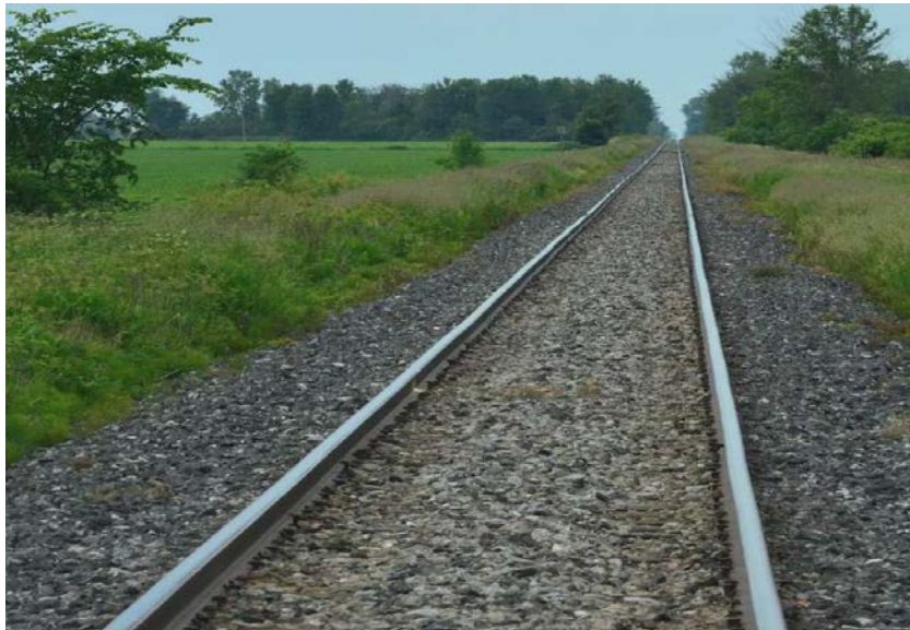
Figure 39 – Tronçon de rail soudé vers le P.M. 19,0
