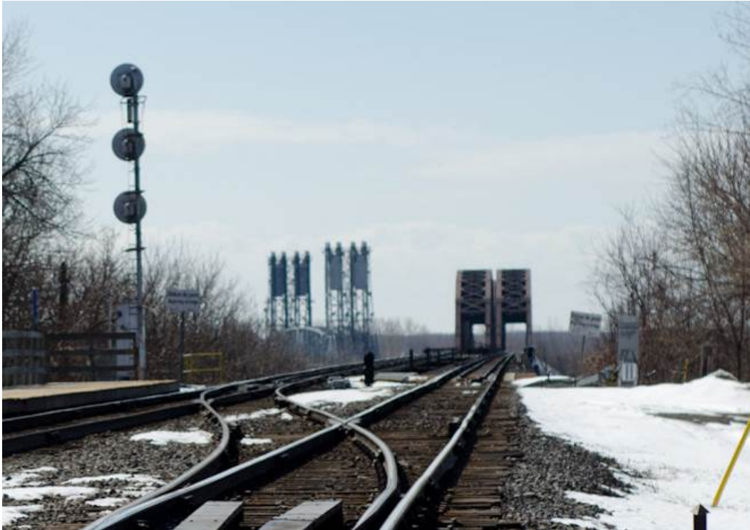
Figure 5 – Pont ferroviaire Saint-Laurent
