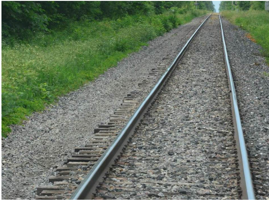
Figure 38 – Usure de l'épaulement vers le P.M. 20,0
