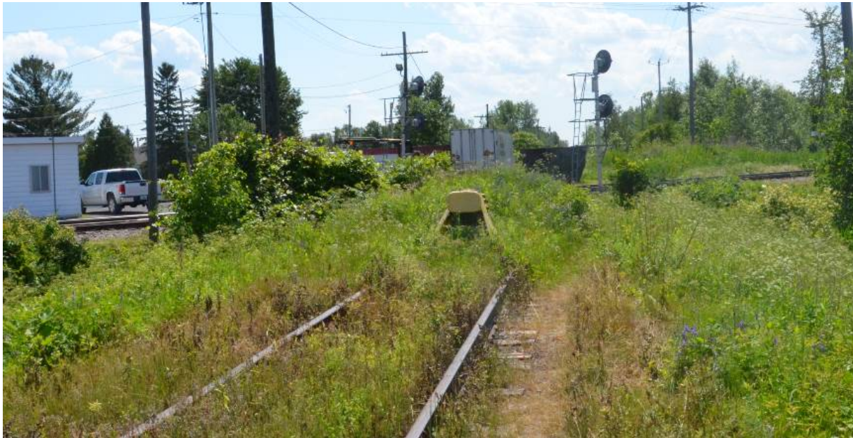
Figure 55 – Fin de l'antenne Massena, au P.M. 77,24, avec voies et signaux du CP en arrière-plan
