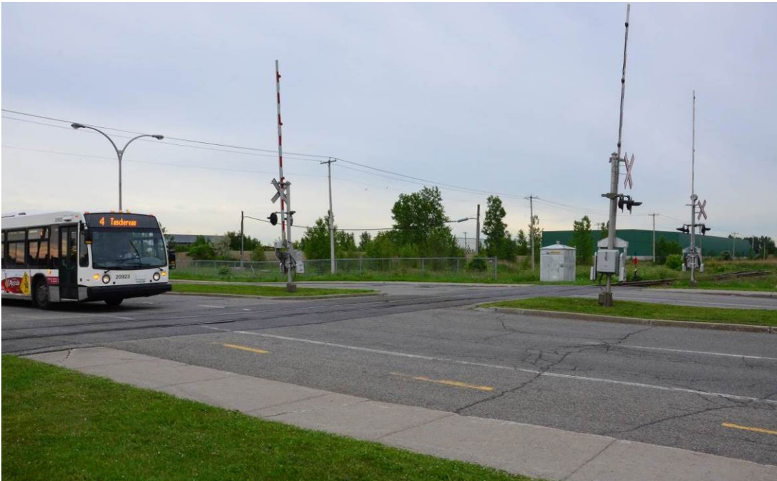
Figure 28 – Passage à niveau à quatre barrières au boul. Payer (P.M. 39,16)
