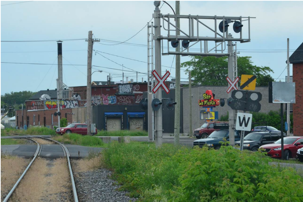
Figure 35 – Passages à niveau des rues St-Jacques et Cousins Nord (photo prise à partir du boul. du Séminaire, P.M. 22,71)
