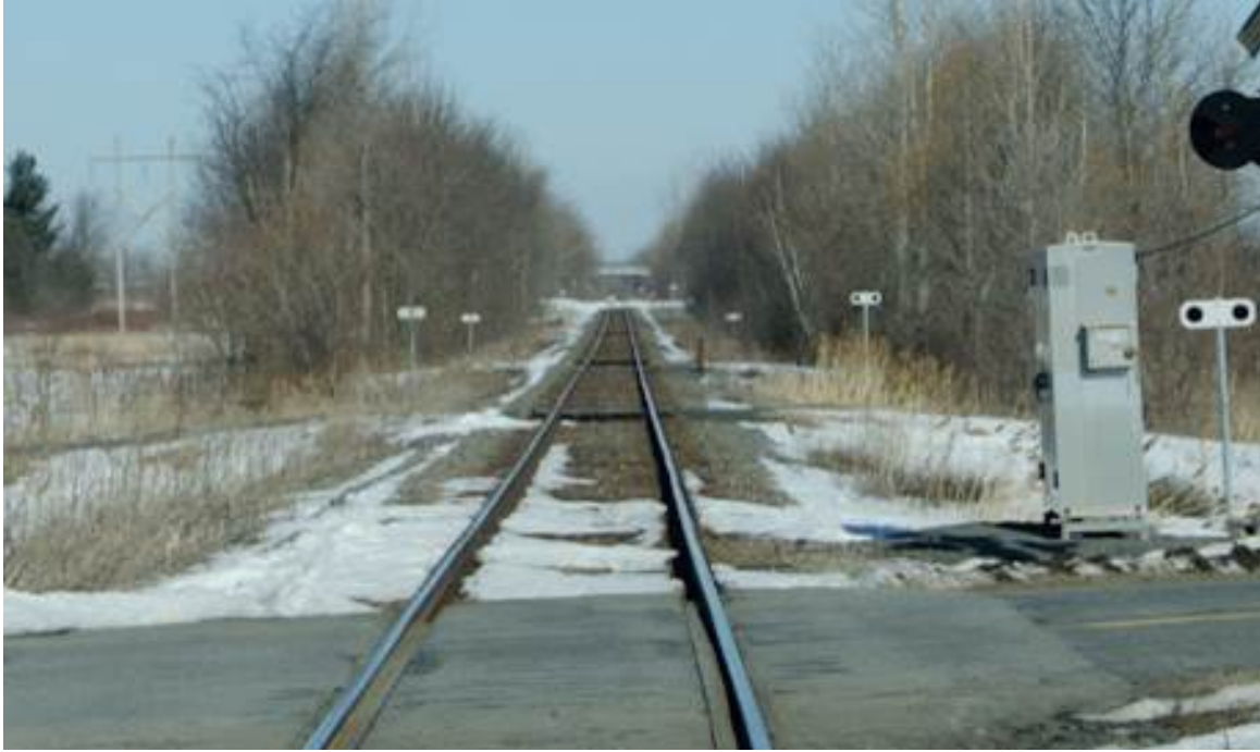
Figure 23 - Succession de 3 passages à niveau de ferme vers le P.M. 17 de la subdivision Lacolle
