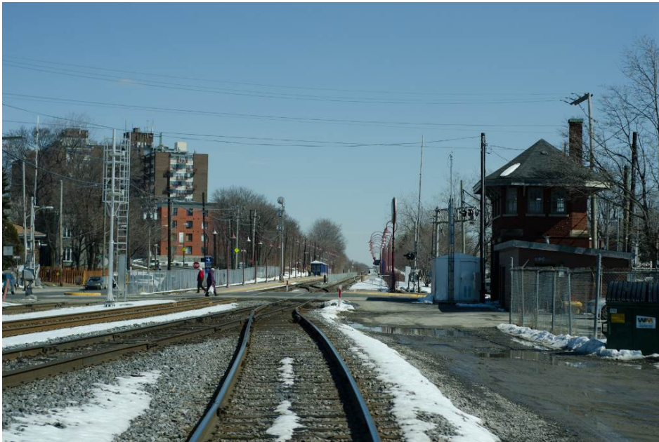
Figure 2 - Abords de la gare Montréal-Ouest Un passage à niveau généralement achalandé à la rue Westminster S. (vue vers l'est)
