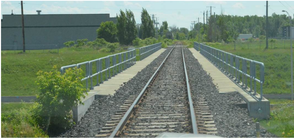
Figure 53 – Pont ferroviaire enjambant la route 132 au P.M. 78,38
