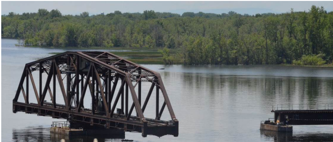
Figure 46 – Pont tournant au P.M. 24,3 (vu de la route 202)
