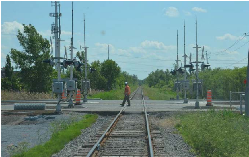
Figure 49 – Passage à niveau au boul. Matte, P.M. 83,3
