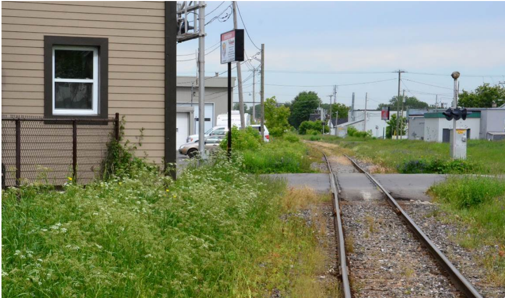
Figure 36 – Bâtiment privé sur la rue Laurier, P.M. 22,3
