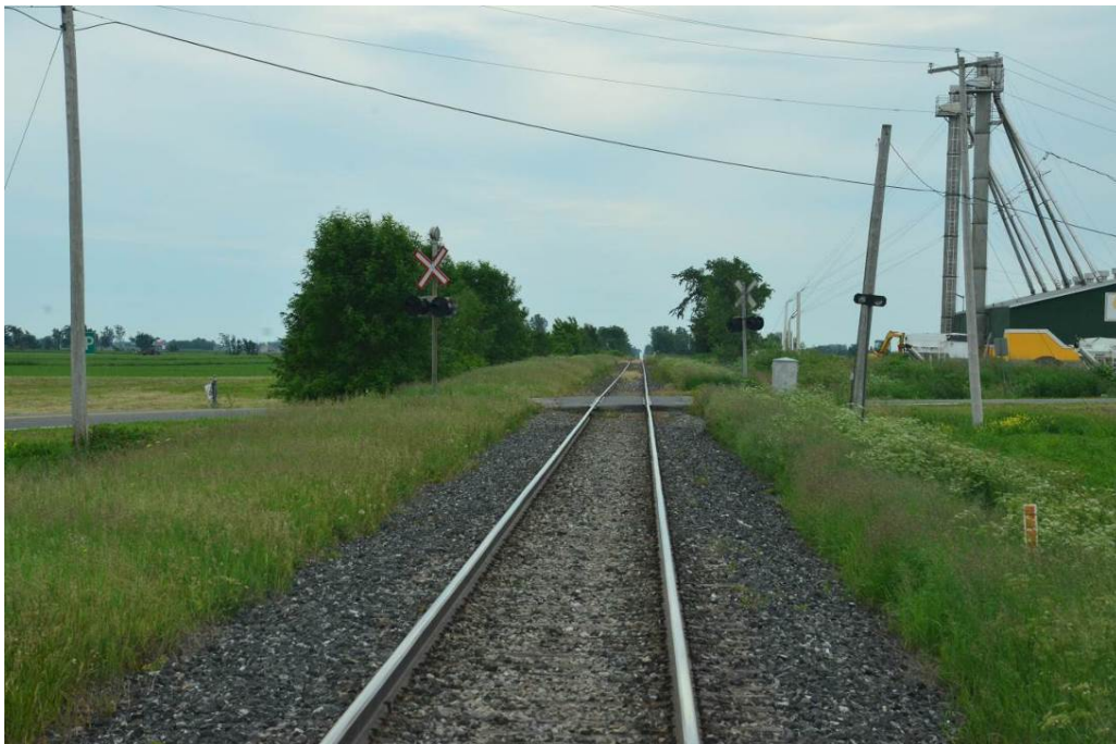
Figure 41 – Passage à niveau public de la Montée de l'Église à Saint-Blaise-sur-Richelieu, P.M. 15,38
