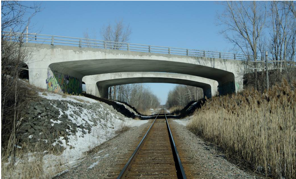
Figure 13 - Pont routier de l'autoroute 15 au P.M. 17,35 à Napierville
