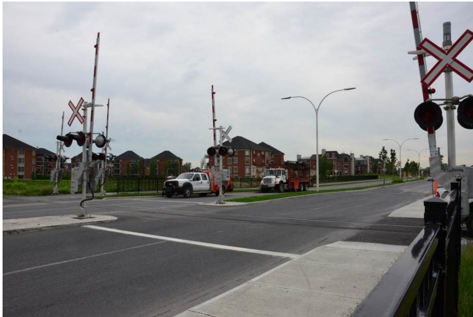
Figure 30 - Le passage à niveau du boul. du Quartier (P.M. 35,57)
