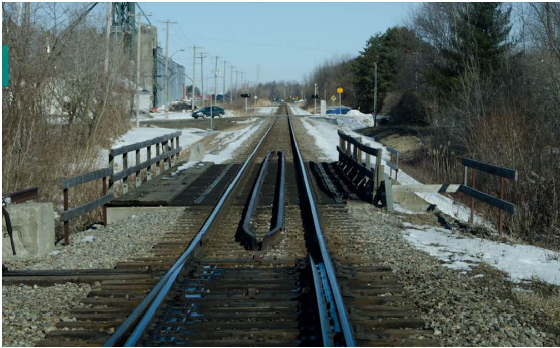
Figure 15 - Pont ferroviaire de la rivière l'Acadie au P.M. 12,64
