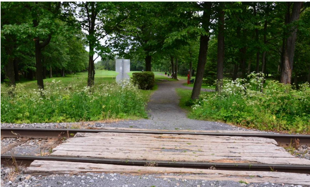
Figure 37 – Passage à niveau privé au Club de Golf de St-Jean au P.M. 20,44
