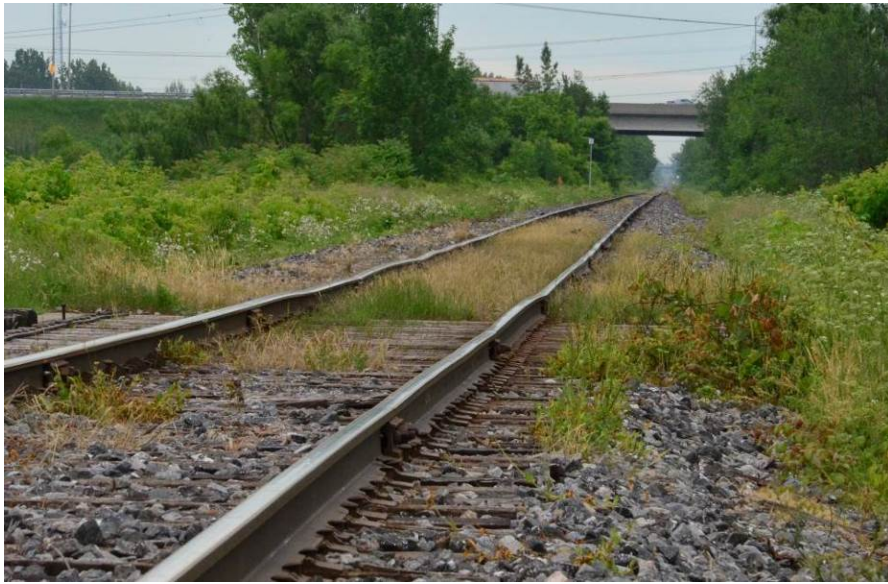
Figure 60 – Effet de la succession de courtes sections boulonnées sur le profil de la surface de roulement vers le P.M. 35,55
