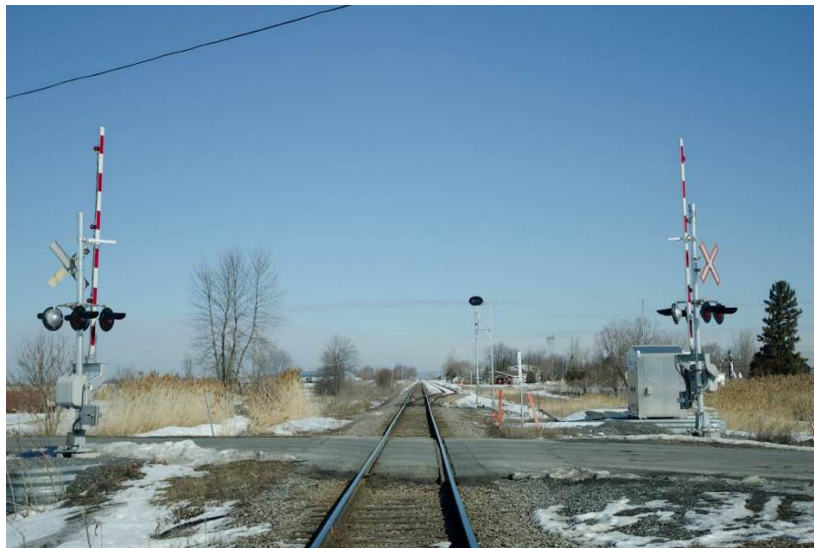
Figure 12 - Passage à niveau de la Montée de la Petite Côte au P.M. 23.07 (avec croix, feux et barrières)
