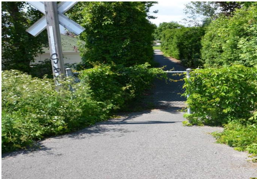
Figure 50 – Chicane pour vélos au passage piétonnier du P.M. 82,30
