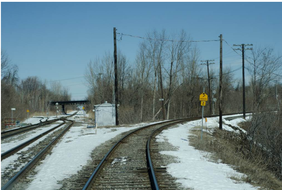
Figure 3 - Embranchement de la subdivision South Junction Lead vers la subdivision Westmount (subdivision Adirondack direction nord à gauche)
