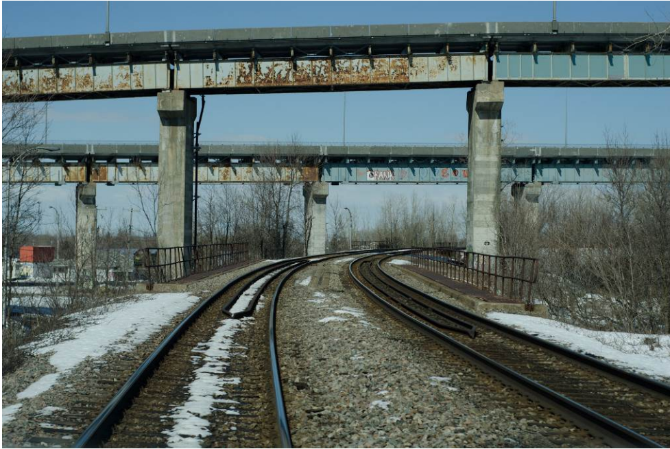
Figure 6 - Courbe passant sous les voies d'accès du Pont routier Honoré-Mercier
