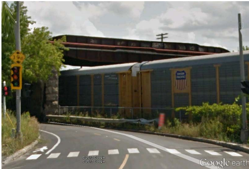
Figure 4 - Pont ferroviaire du CP enjambant la voie du CN au sud de la jonction entre les subdivisions South Junction Lead et Adirondack
