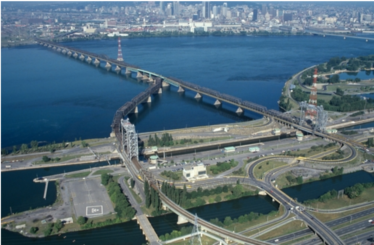
Figure 25 - Deux sections du pont levant enjambant la voie maritime au pont Victoria
