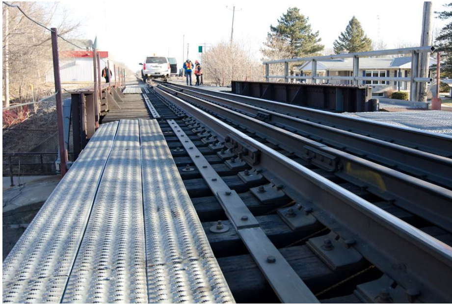
Figure 20 - Pont ferroviaire de la rue Van Vliet au P.M. 4.87
