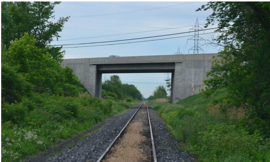
Figure 31 – Pont routier de la route 104 au P.M. 32,59
