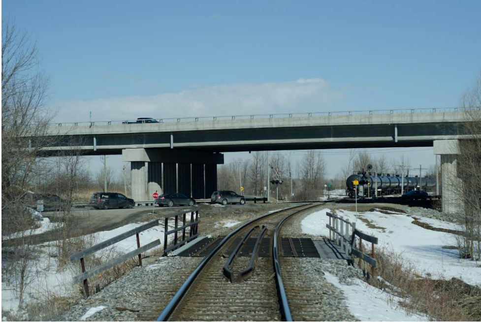
Figure 10 - Passage à niveau de la rue St-Ignace au P.M. 26.25 (lequel coïncide avec le passage sous l'autoroute 30)
