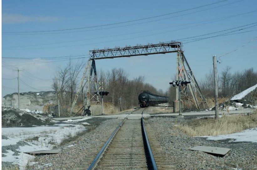
Figure 11 - Passage à niveau privé des Ciments Lafarge, P.M. 25,53
