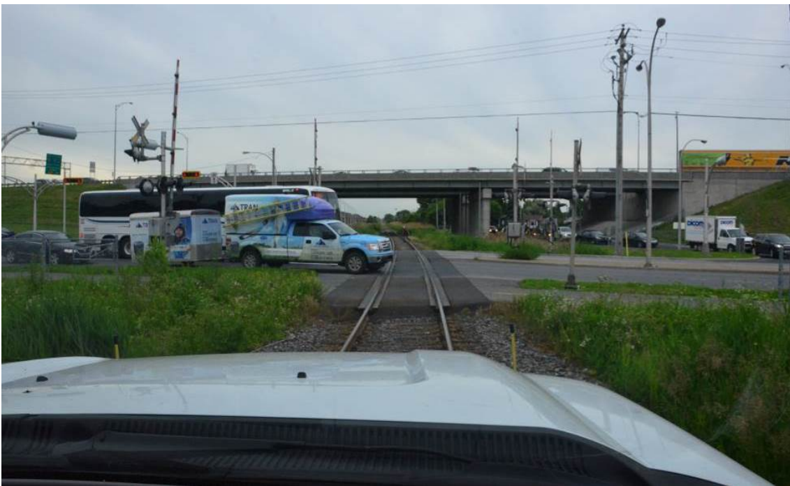
Figure 29 – Passage à niveau de la rue Lapinière et du pont routier de l'autoroute 10 (P.M. 37,62)
