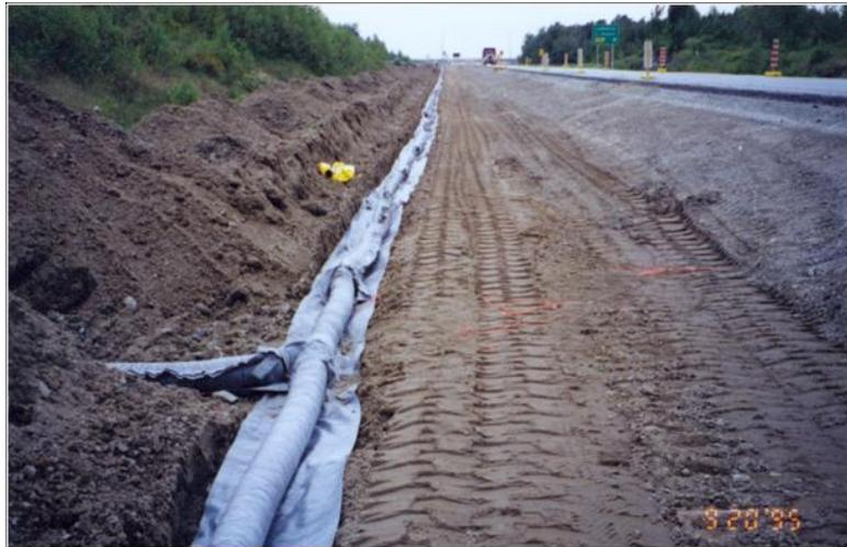
**Figure 49**      **Tuyau de drainage à l'infrastructure**
