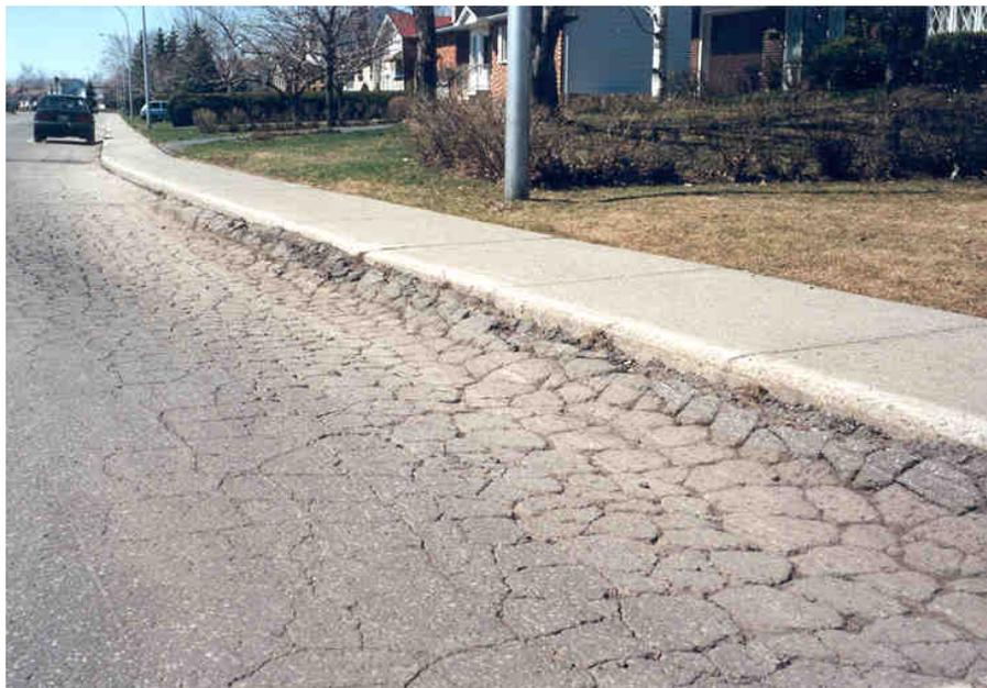
**Figure 8 Fissures créées par un excès d'eau au printemps dans la fondation**
