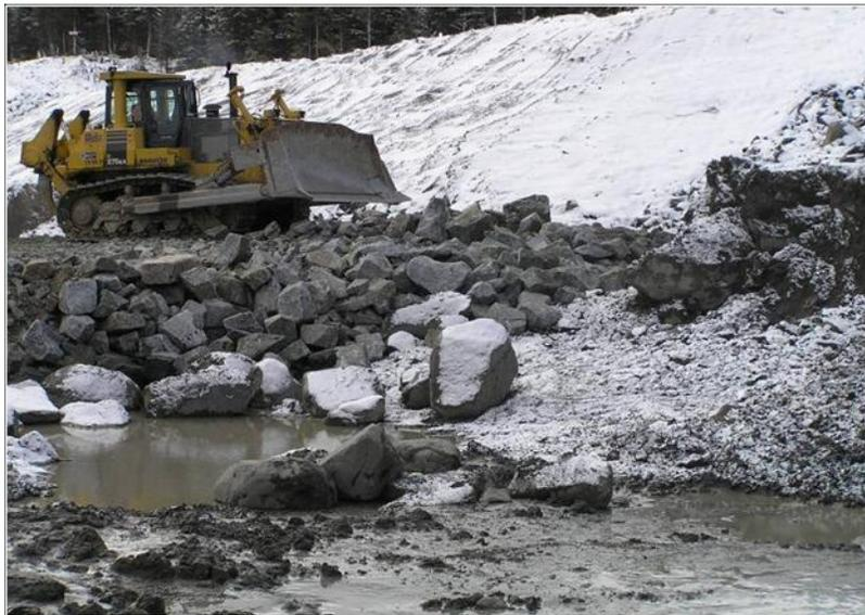
**Figure 39** Enrochement utilisé sur la route 175 dans un déblai de sable silteux
