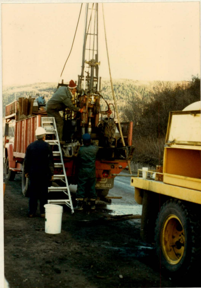
Photo no 5: Forage en préparation, puits S-1
