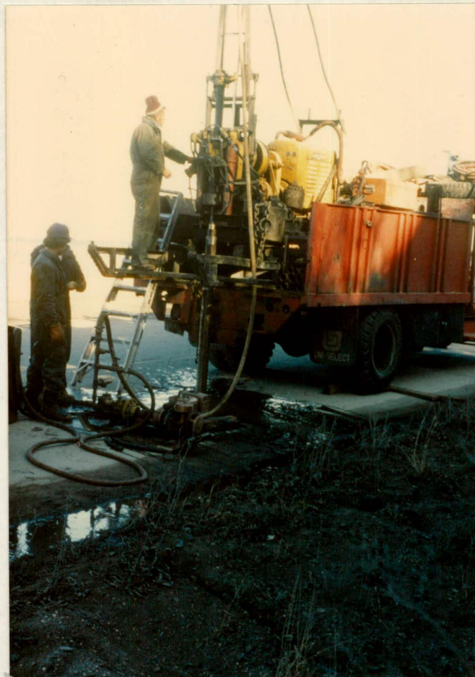
Photo no 6: Forage du puits S-1 en cours
