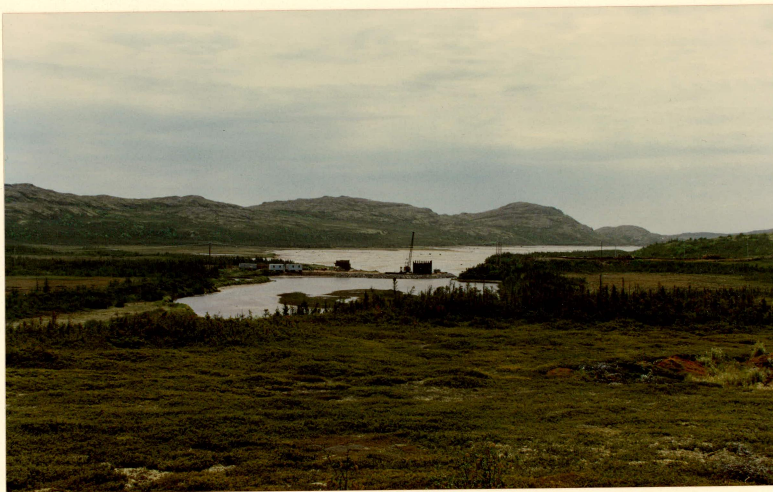
Figure 9 Ruisseau de la baie au Saumon: le pont en construction
