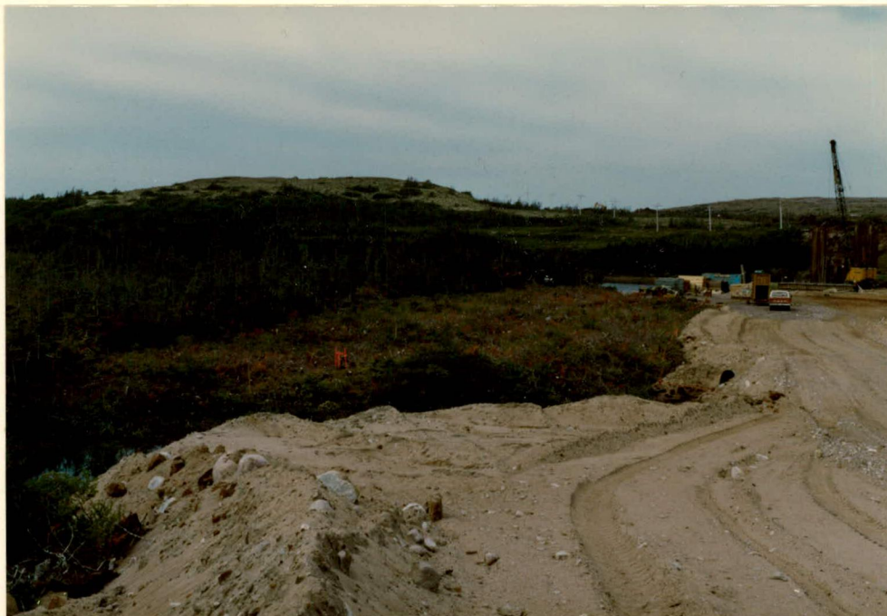
Figure 10 La route 138 en construction et son emprise nord défrichée
