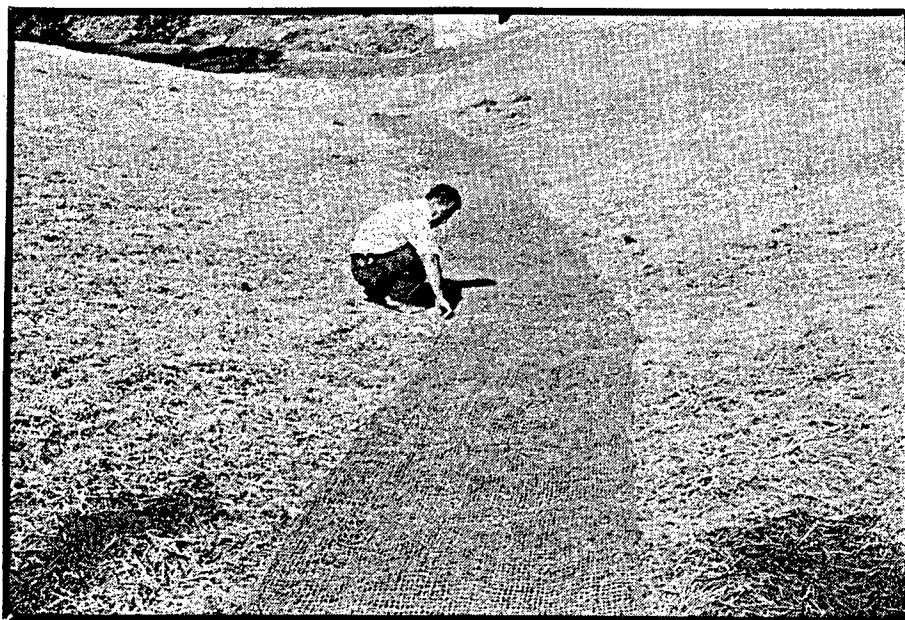
PHOTO 9: Filet de jute installé sur un paillis végétal.
