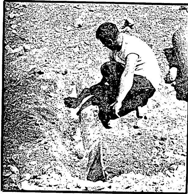
PHOTO 32: Natte de fibre de verre installée dans une tran- chée .
