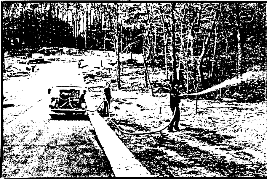
PHOTO 15: Un liant chimique est appliqué sur une surface dénudée qui seraensemencée à une date ultérieure.
