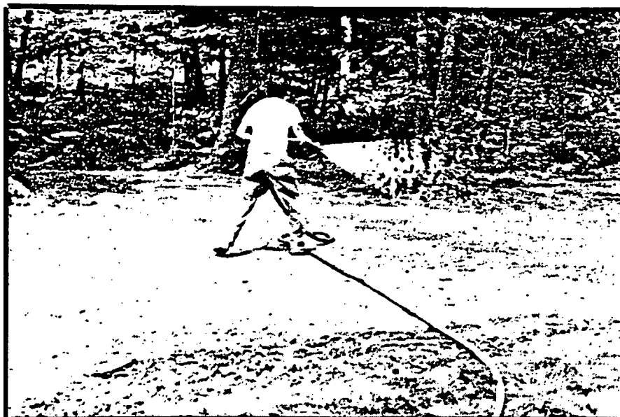
PHOTO 17: Paillis chimique appliqué simultanément avec de la chaux, des fertilisants et des semences.
