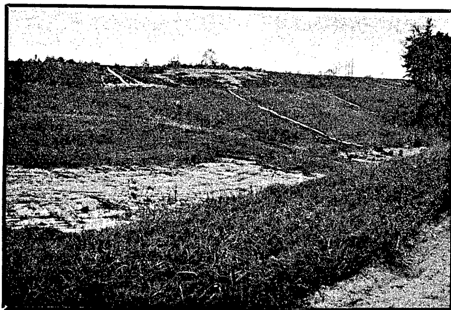
PHOTO 25: Tuyaux flexibles installés sur une pente sujette à l'érosion
