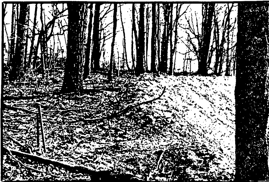
PHOTO 23: Remblai de dérivation construit par un tracteur qui a gratté le sol de bas en haut, laissant une crête de sol au sommet.
