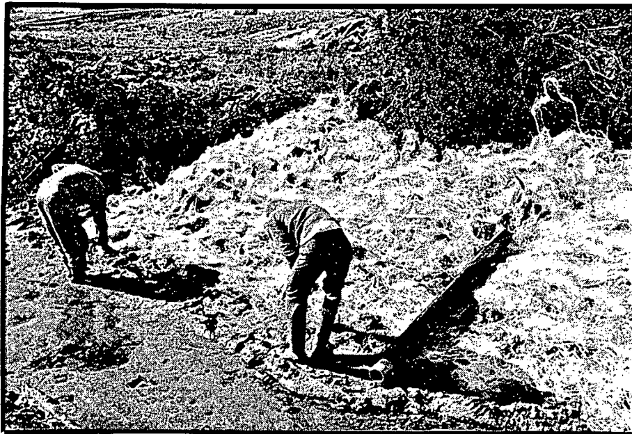
PHOTO 5: Surface traitée avec de la fibre de verre (Glass-root).
