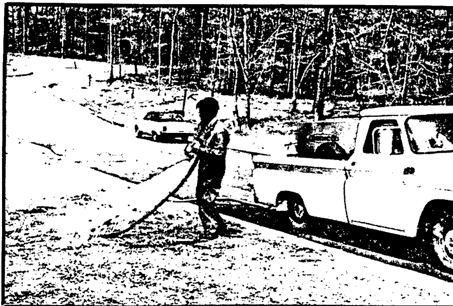
PHOTO 16: Liant chimique appliqué sur un paillis végétal.
