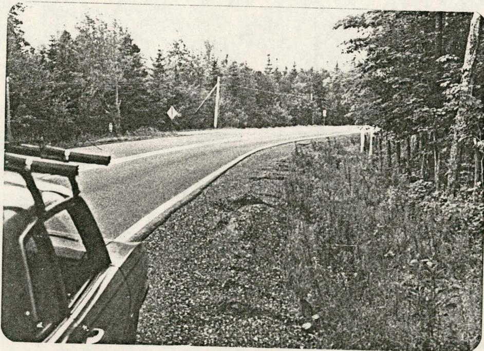
Route 112. 1.6 mille après St-Ange (direction ouest), ravinement & mauvais drainage.
