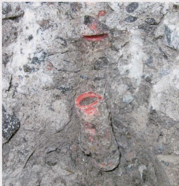
Figure 17 : Extrémité supérieure de la barre R3WS, dalle 3Ba
