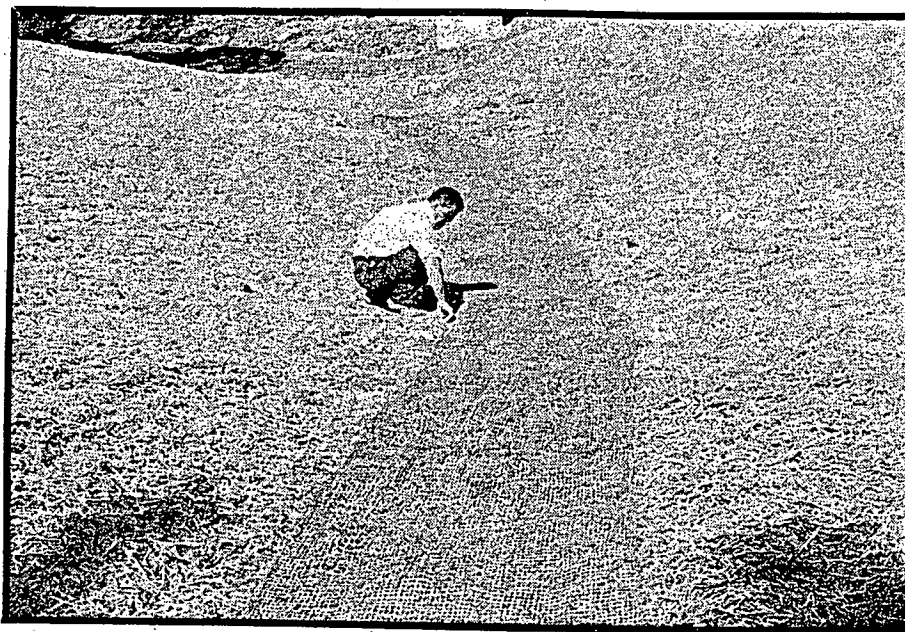
PHOTO 9: Filet de jute installé sur un paillis végétal
