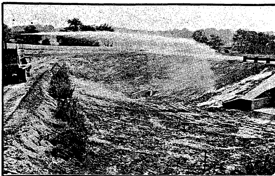
PHOTO 14: Application de fibres de bois à l'aide d'un hydrosemoir calibré
