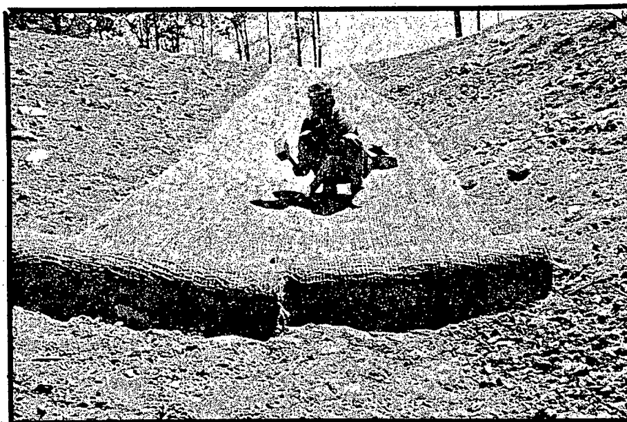
PHOTO 8: Installation d'un filet de jute.
