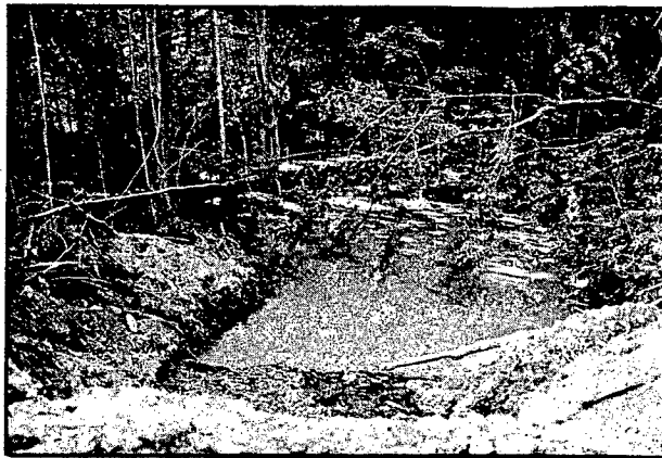
PHOTO 33: Un bassin d'urgence pendant la phase de défrichement
