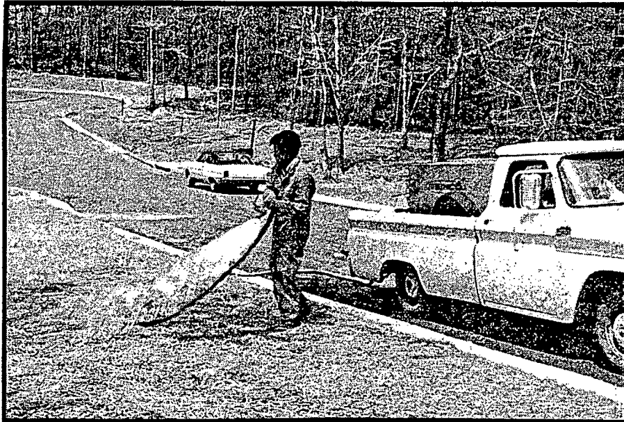
PHOTO 16: Liant chimique appliqué sur un paillis végétal
