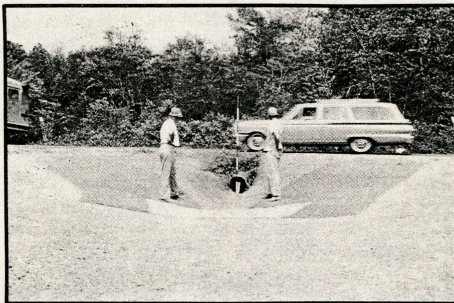
PHOTO 3: Natte de fibre de verre installée près d'un pontceau
